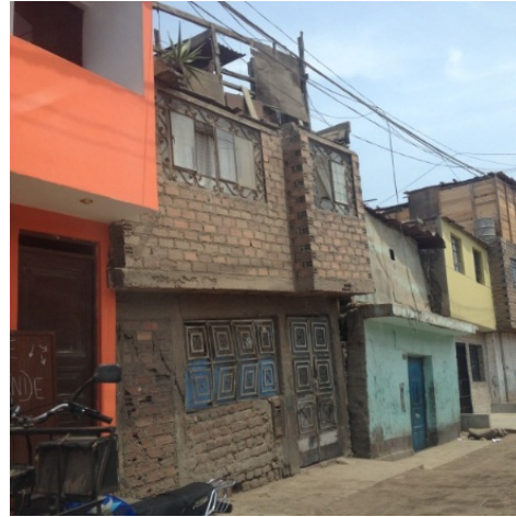
Figura 55. Edificaciones cercanas Elaboración: el autor
