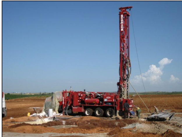
Figura 28 Maquinaria empleada en la perforación por rotación
