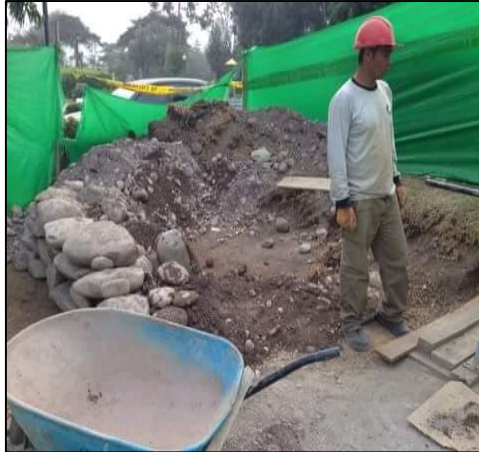
Figura 19 Acarreo de material excedente en pozo
