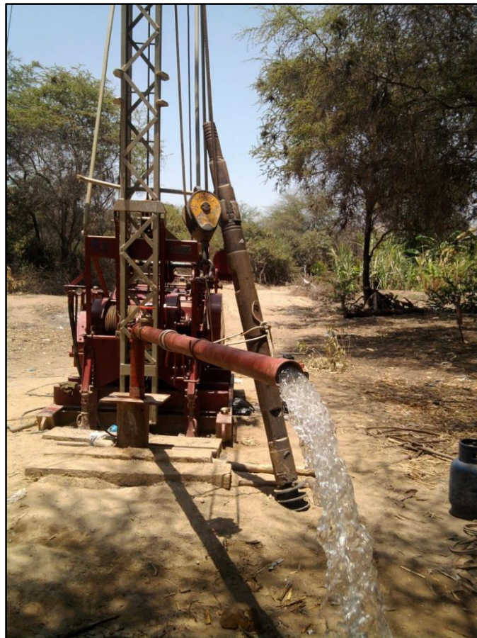
Figura 32 Prueba de bombeo
