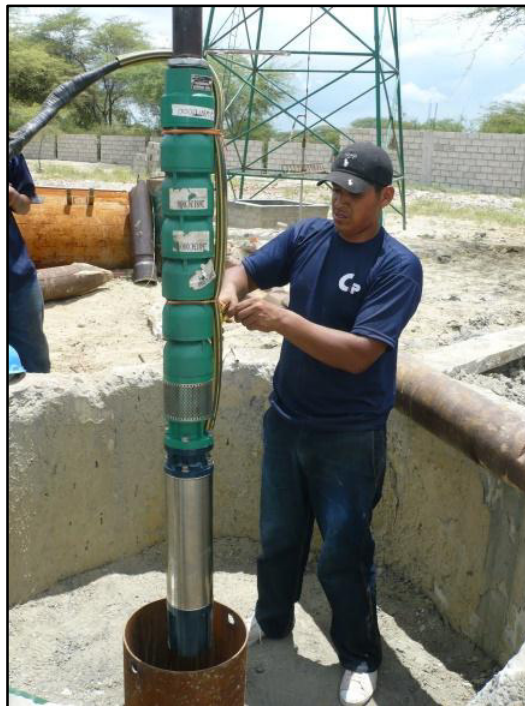
Figura 26 Prueba de bombeo en pozos
