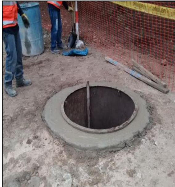
Figura 17: Anillo de concreto
