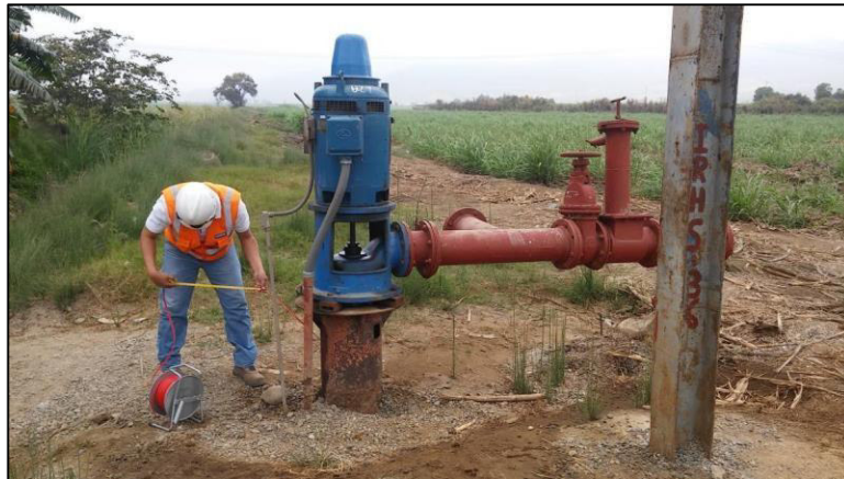
Foto N° 11.- Medición del nivel estático en el pozo IRHS 36 "Q-29", sector San Andrés
