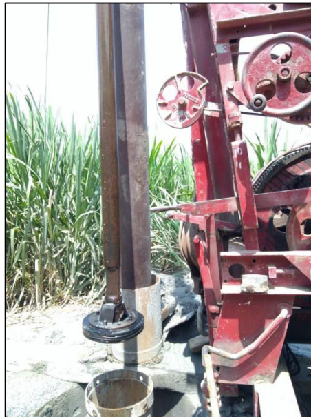
Figura 25 Pistón empleado para el desarrollo del pozo
