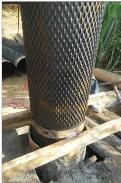
Figura 31 Colocación tubería de filtro
