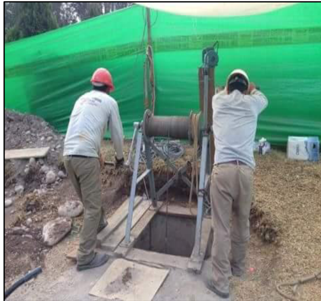
Figura 18 Uso de manivela para extracción de material excedente
