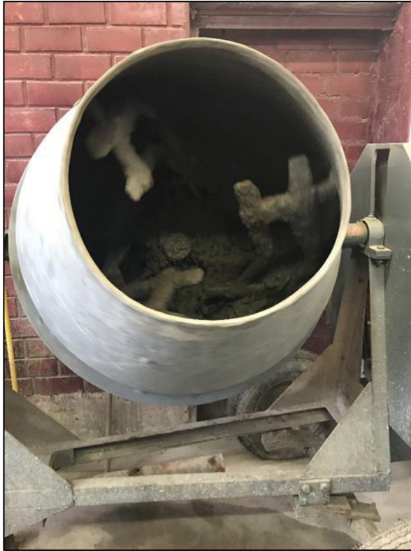
Figura 32: Mezclado del concreto Elaboración: los autores
