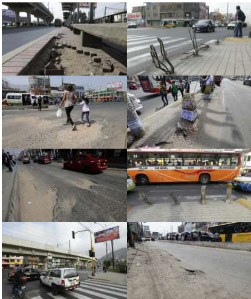
Figura 73: Evaluación de la infraestructura vial en los distritos de Lima Metropolitana. Fuente: Defensoría del Pueblo (2015), la Adjuntía del Medio Ambiente, Servicios Públicos y Pueblos Indígenas, Recuperado de: https://elcomercio.pe/lima/transporte/notepases-deficiente-peligrosa-infraestructura-vial-lima-noticia-522799?foto=5 .
