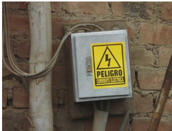
Figura 165. Señalización realizada después de la capacitación.
