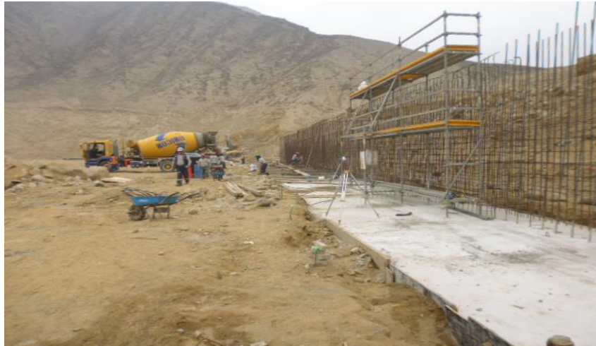
Vaciado de cimentación
