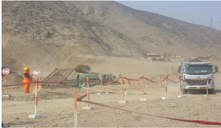
Eliminación de material excedente
