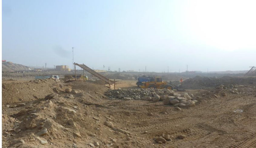
Vista área de excavación masiva
