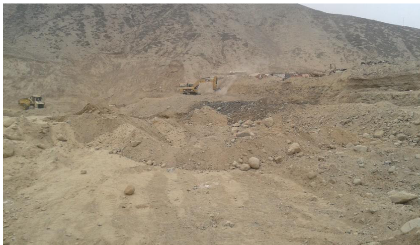
Area de excavación masiva
