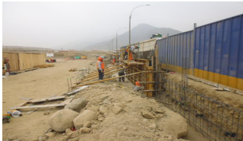
Encofrado de muros bajos
