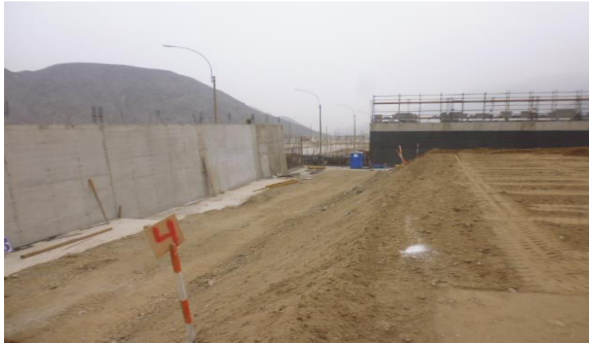
Muros de contención
