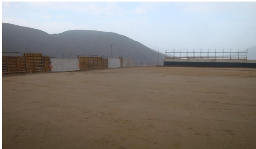
Area de relleno estructural
