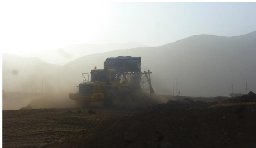
Zarandeo y eliminación de exceso de finos
