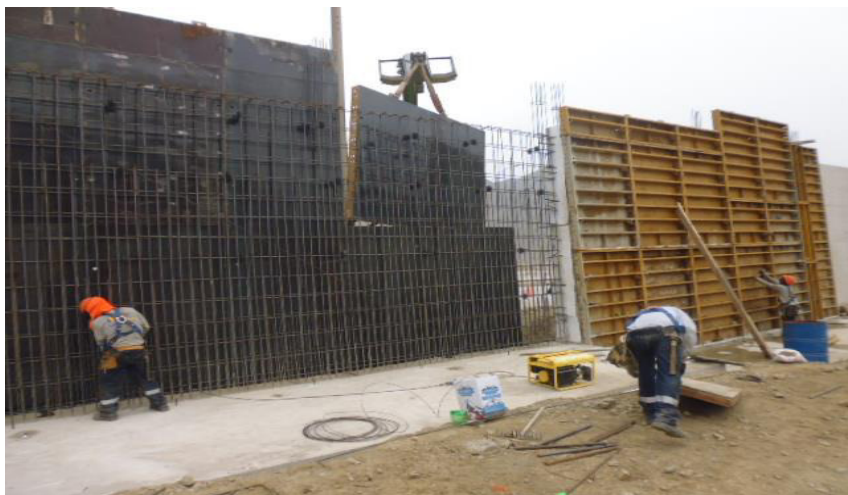
Colocación de armadura de acero
