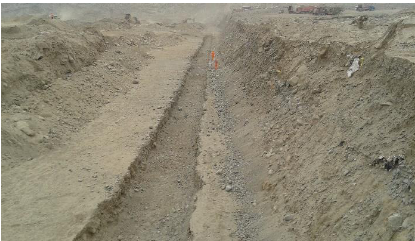
Zanja para cimentación de muros
