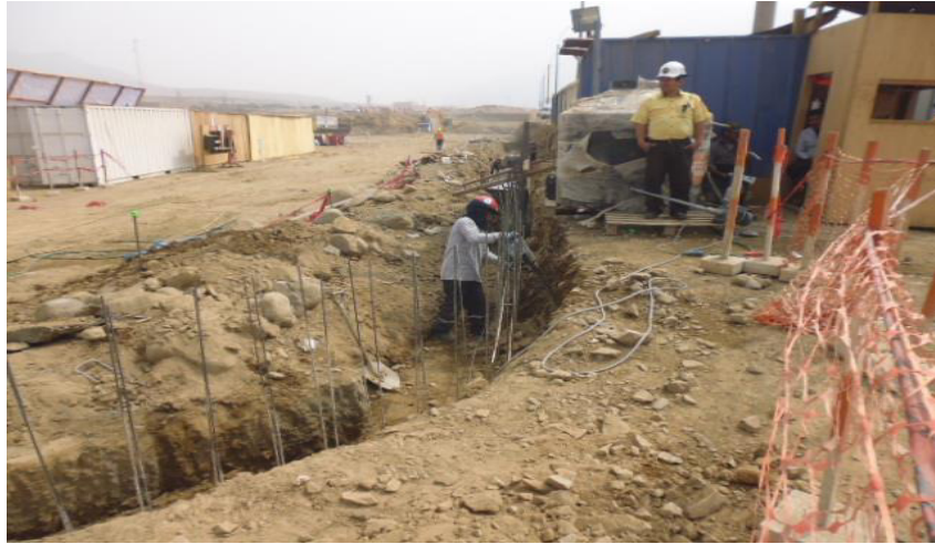
Armadura de acero
