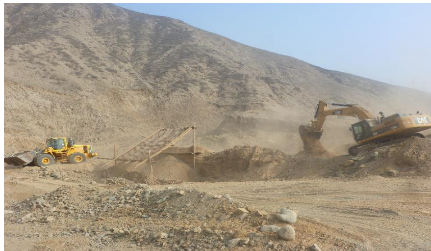
Proceso de zarandeo del material
