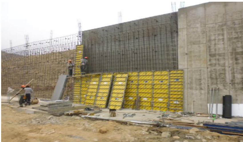
Encofrado de muros de contención
