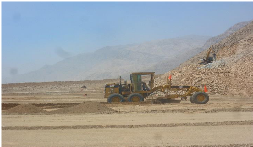
Nivelación del relleno
