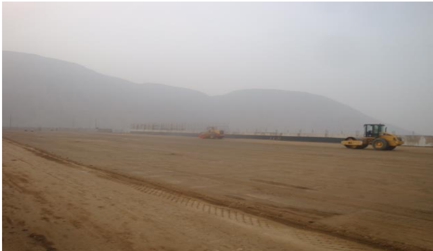
Compactación del área de relleno
