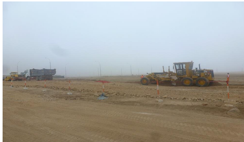
Nivelación de las franjas de compactación
