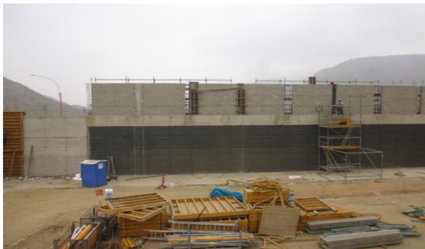
Muro de tabiquería armada
