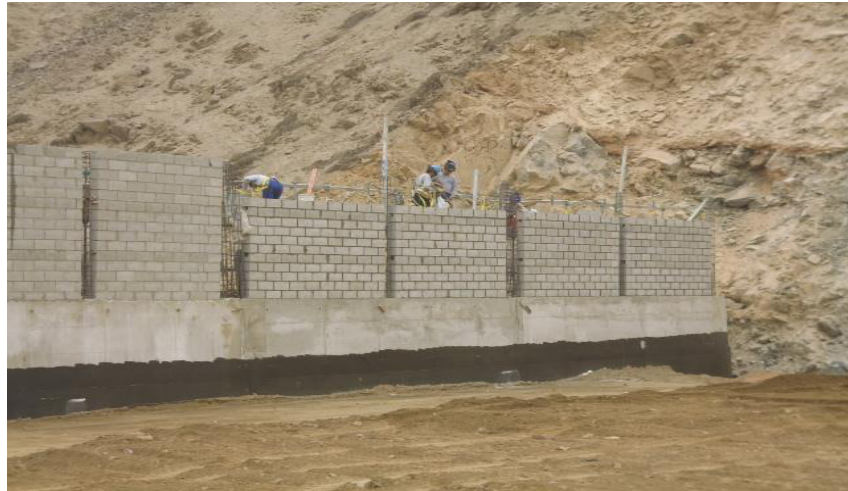
Levantamiento de muro de bloques
