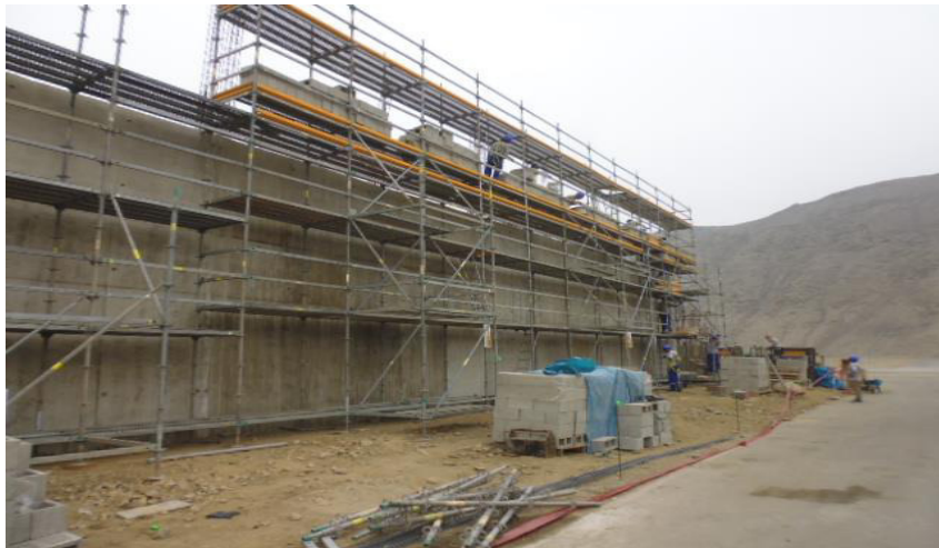
Andamios para trabajos en altura
