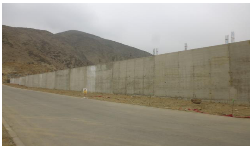
Vista exterior de muros de contención
