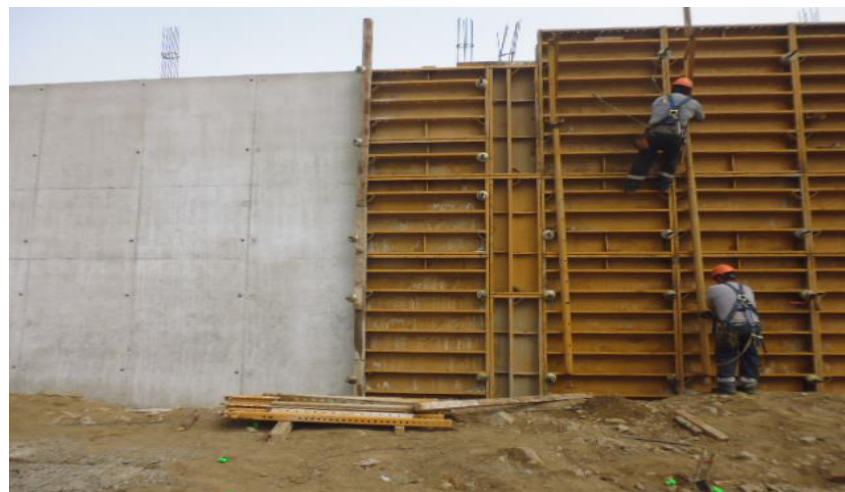
Encofrado de muros altos
