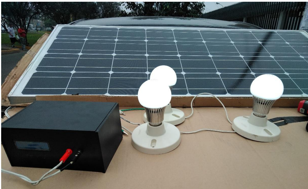
FIGURA 41: Implementación del diseño circuital con el sistema del panel solar
