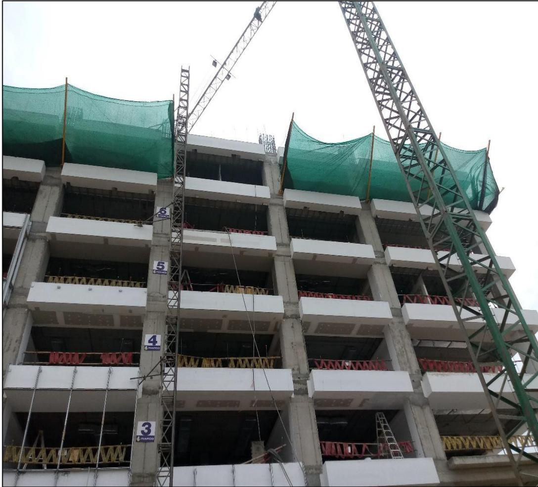
**Fotografía 1:** Avance de Instalación de muro cortina del proyecto
