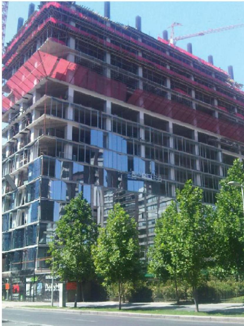
**Fotografía 2:** Avance de instalación de muro cortina en edificio oficinas Olgún y pantallas de seguridad.
