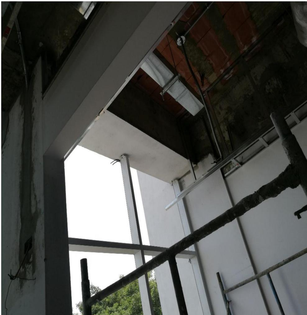
**Fotografía 8:** *Instalación de Muro Cortina entre vanos*
