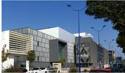
Figura N° 20: Vista exterior del Centro de innovación tecnológica del entretenimiento.
