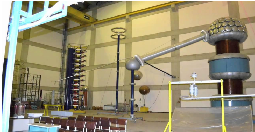
Figura N° 33: Laboratorio de alta tensión.
