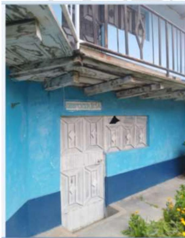
Se aprecia rajaduras en la edificación y mal estado de conservación de la escalera.
