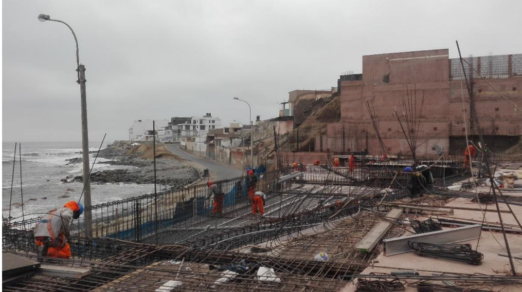
Anexo 27. Fotografía del Condominio Ocean Reef - Armado de acero en Piscina de Área Común Sótano 4. Primera Etapa
