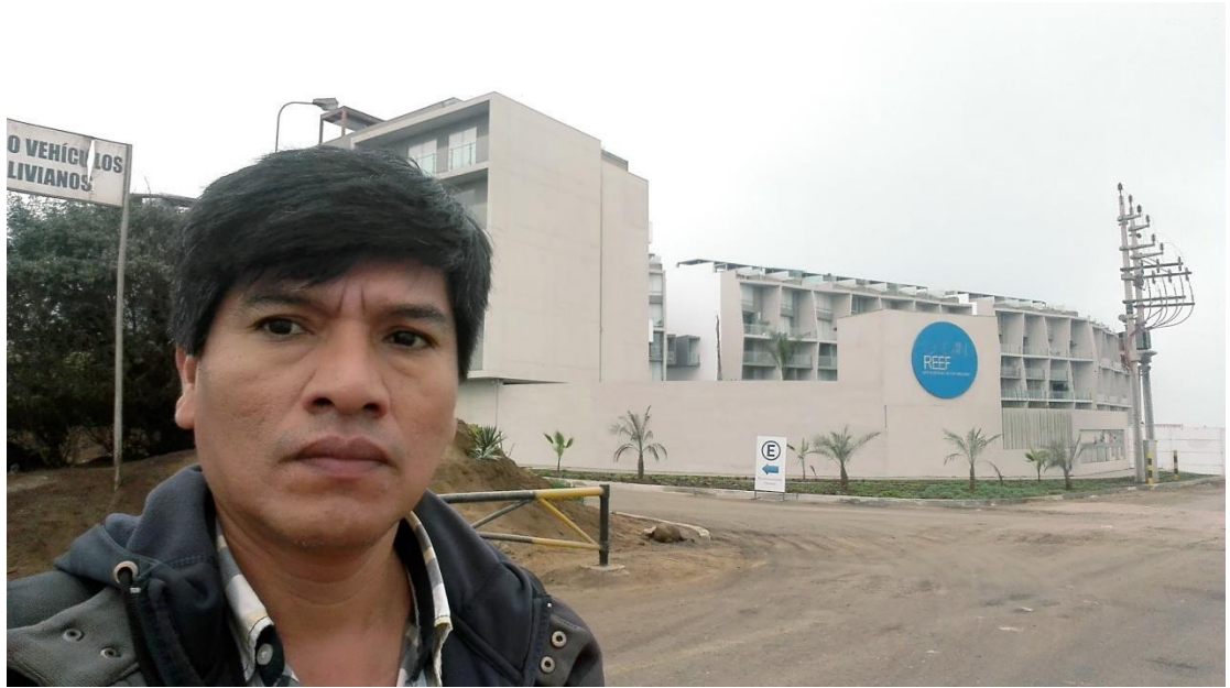
Anexo 25. Fotografía del Condominio Ocean Reef - Primera Etapa. San Bartolo. Esquina de las Avenidas Piedras Negras y Del Golf
