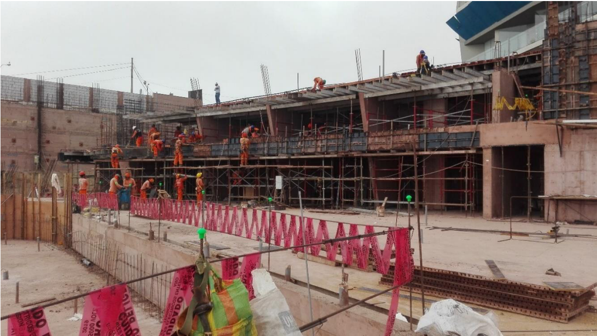
Anexo 33. Fotografía del Condominio Ocean Reef - Encofrado Techo Sótano 3 de Área Común. Primera Etapa
