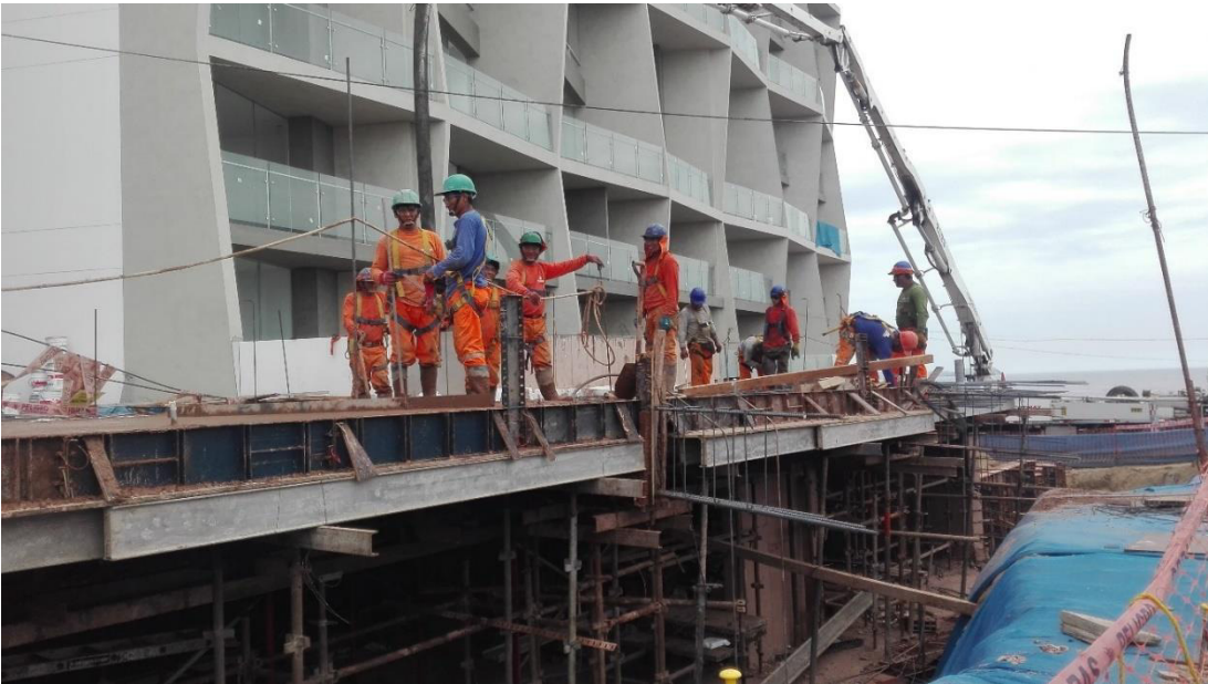
Anexo 34. Fotografía del Condominio Ocean Reef - Encofrado Techo Sótano 1 de Área Común. Primera Etapa
