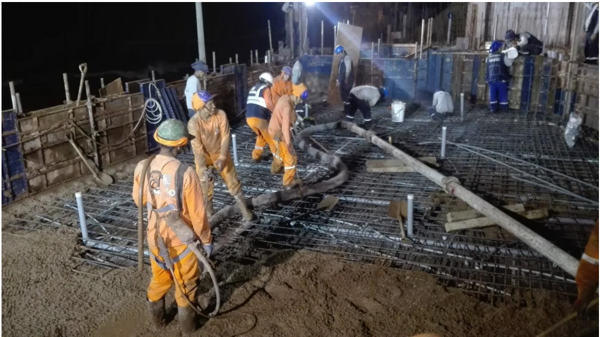
Anexo 32. Fotografía del Condominio Ocean Reef - Vaciado de concreto en Piscina Sótano 4. Primera Etapa
