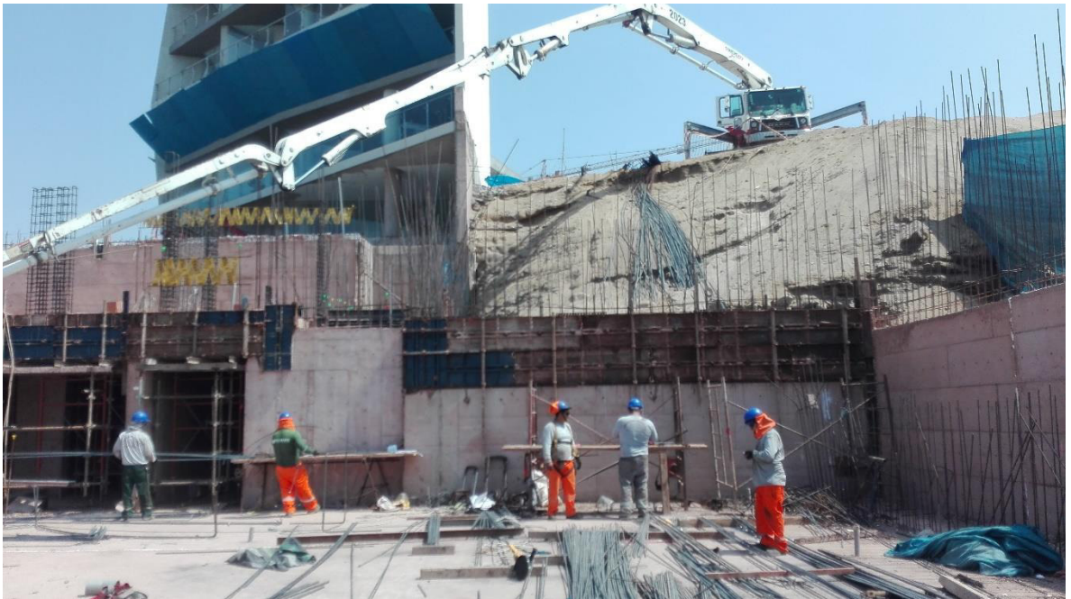
Anexo 30. Fotografía del Condominio Ocean Reef - Bomba Concretera en vaciado Sótano 4. Primera Etapa
