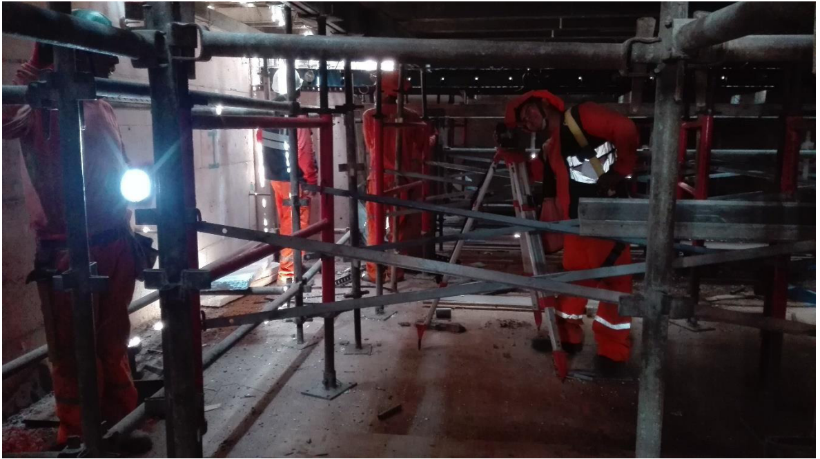
Anexo 29. Fotografía del Condominio Ocean Reef - Nivelación de Encofrado de losa en Piscina de Área Común Sótano 4. Primera Etapa
