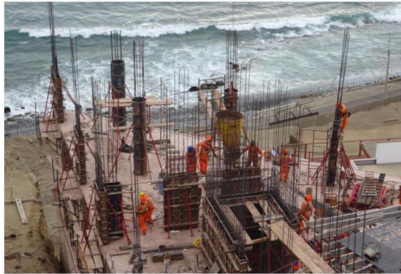
Figura 20. Vaciado de muros - Proyecto Ocean Reef
