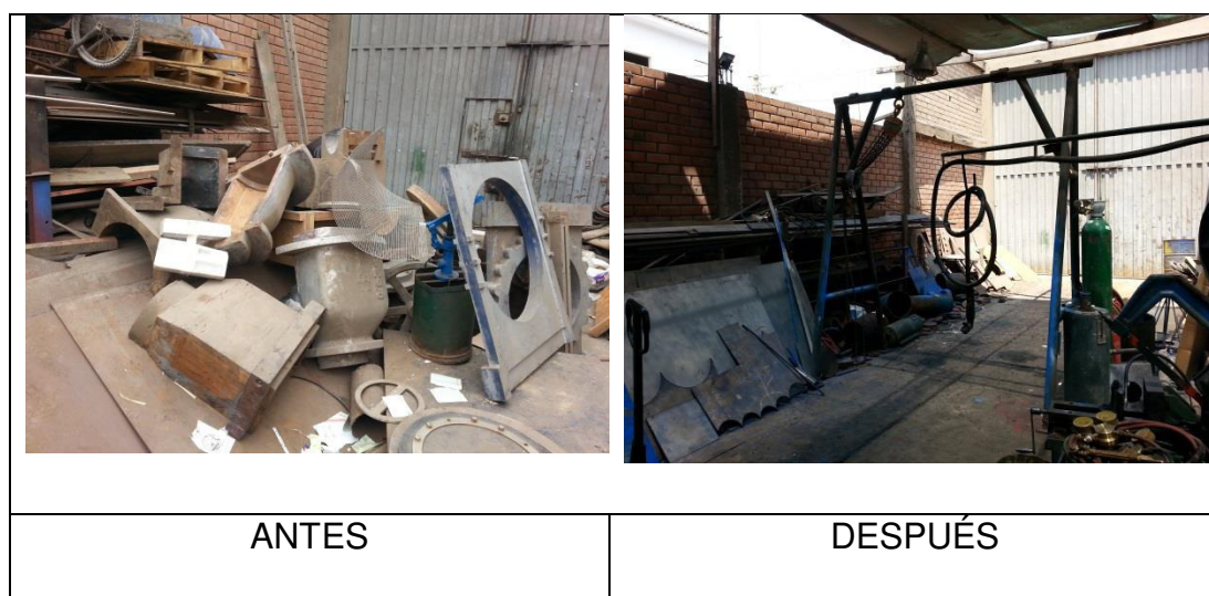
Figura 49. Limpieza en el área de producción 1
