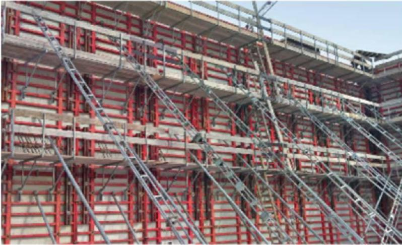
Por estar dotado de la placa plástica alkus y por la perfecta simetría de la disposición de juntas y puntos de anclaje, Mammut 350 es ideal para obras con grandes exigencias a la superficie del concreto.
