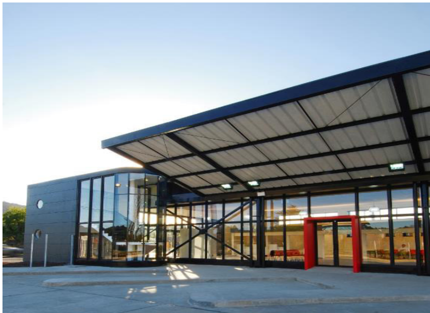
Figura N° 5: Fachada principal terminal de buses los lagos
