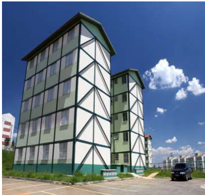
Figura 2: Edificio Multifamiliar Fuente: Porto Maravilha (2012)
