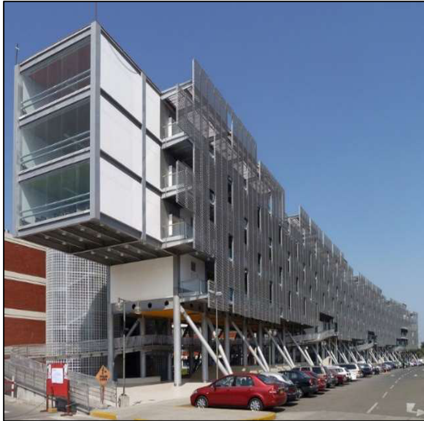
Figura 8: Edificio de acero estructural Fuente: Arquitecturapanamerica
