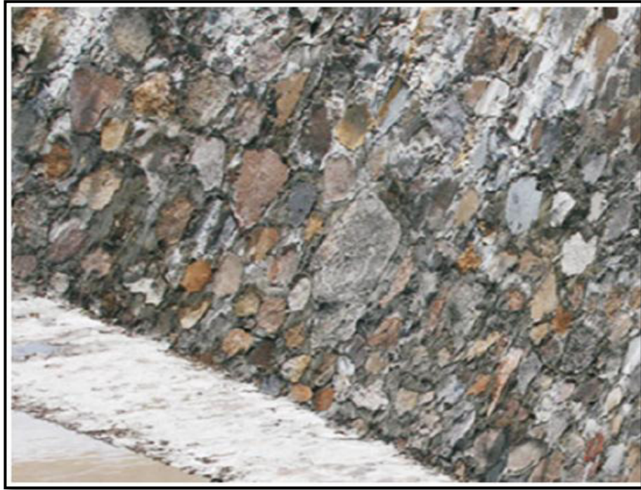
Figura: 4 Muro de contención ciclópeo
