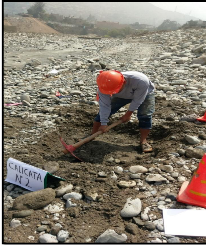
Figura 50: Excavación de Calicata 2 – Elaboración: el autor
