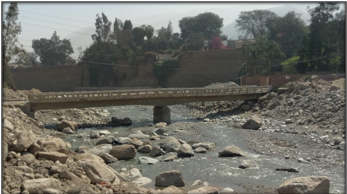
Figura 45: Foto ancho del puente-- Elaboración: el autor
