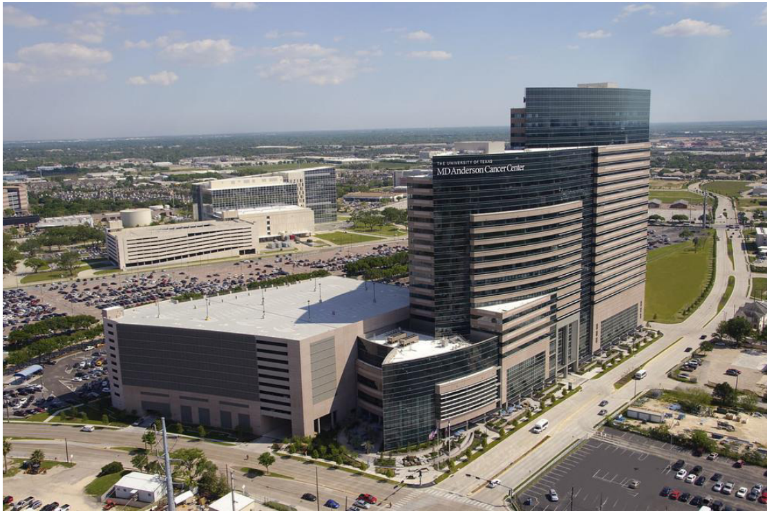
Figura № 30: Fachada del MD Anderson Hospital Fuente: Imágenes de Google
