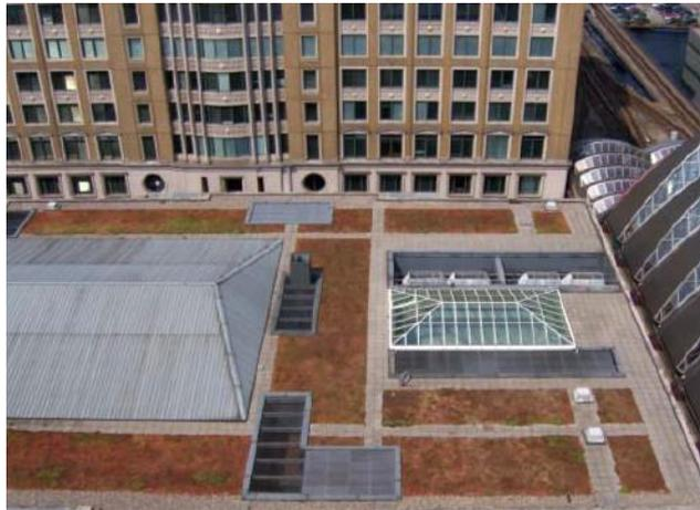
**Figura N° 5. Techos Sedum en edificio comercial, Canary Wharf, al este de Londres.**
