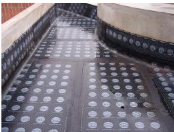
**Figura N° 3. Losa con primera capa de lámina impermeabilizante mastico de bitumen.**
