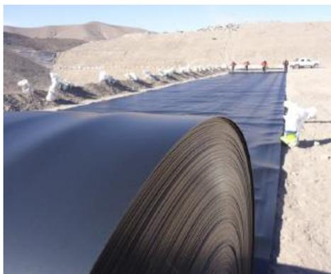
**Figura N° 8. Instalación y suministro de geomembrana de HDPE.**
