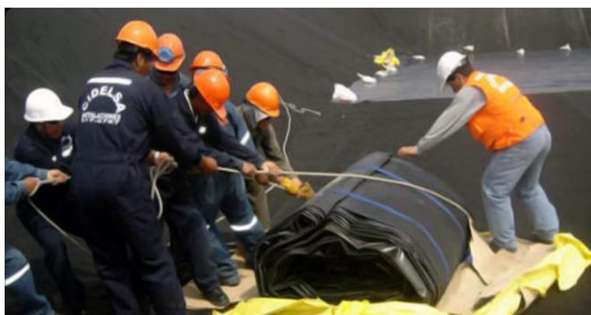
**Figura N° 7. Geomembrana de PVC.**
