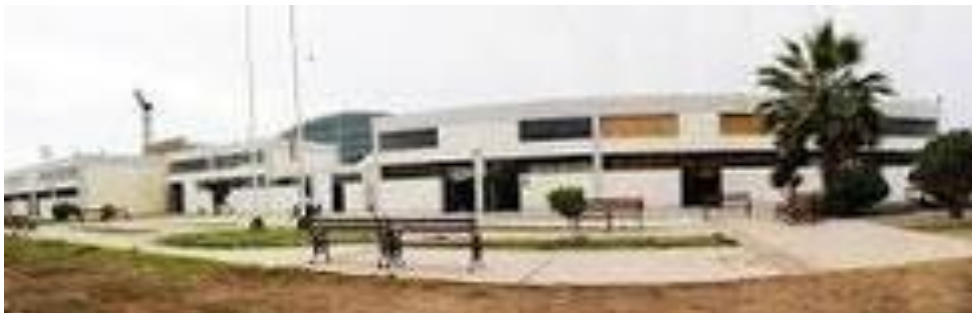
Figura 5 Fachada CETPRO Alcides Salomón Zorrilla
