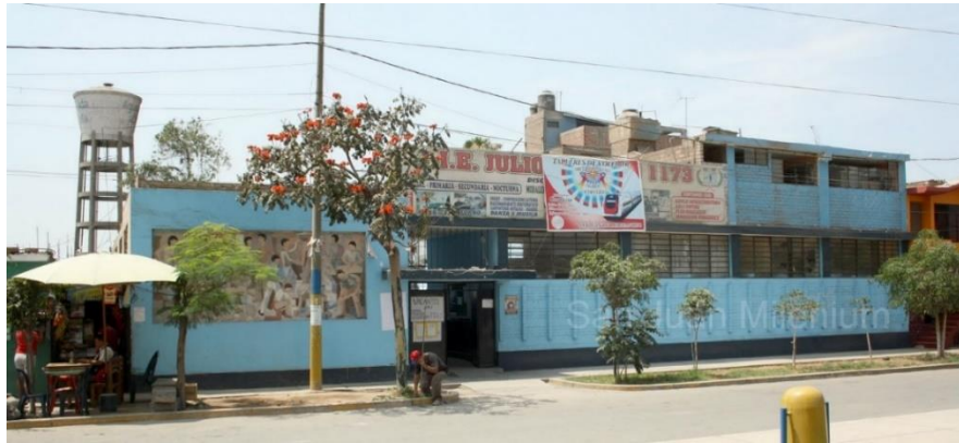
Figura N°99: Colegio Julio C.Tello, ubicada frente de la Plaza el Pueblito Fuente: Propia
