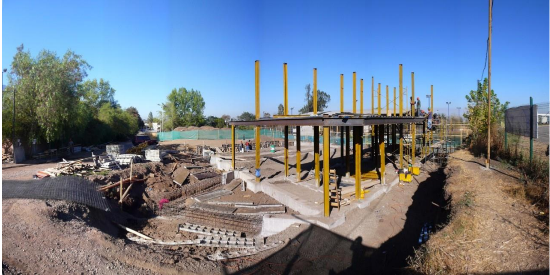
Figura N°34: Estructura y cimentación, Centro de Artes Aéreas, Chile Fuente: http://www.archdaily.pe/pe/02-220517/centro-de-las-artes-aereas-dx-arquitectos/50da6e6db3fc4b21890003a6-acrobatic-arts-center-dx-arquitectos-image
