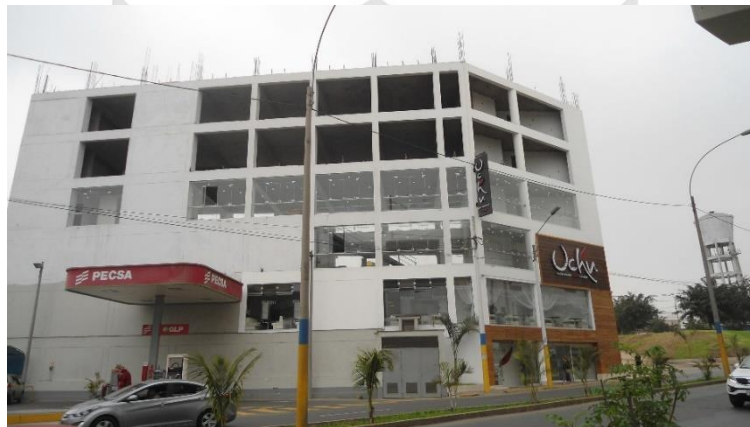
Figura N°97: Edificio comercial, Av. Próceres de la Independencia. Fuente: Propia
