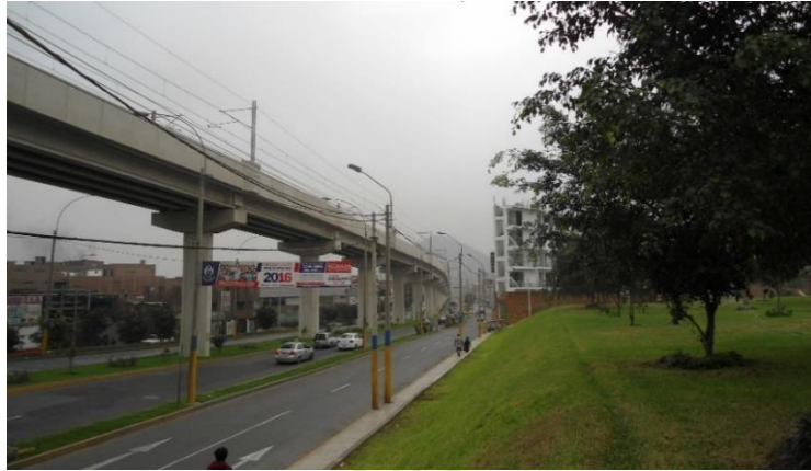
Figura N°90: Parque S/N y Av. Próceres de la Independencia Fuente: Propia
