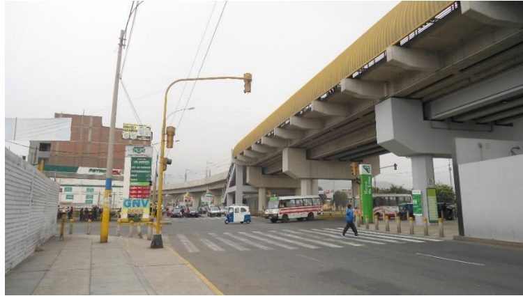
Figura N°93: Cruce de la Av. Próceres de la Independencia con calle Líquenes y estación Pirámide del Sol del Metro de Lima I Fuente: Propia
