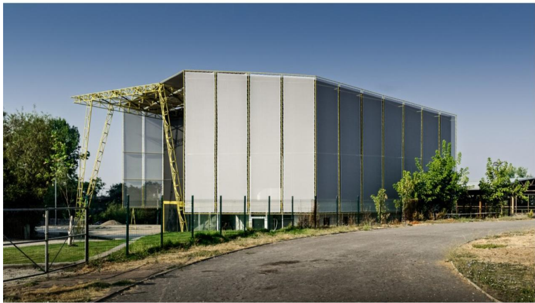
Figura N°32: Ingreso, fachada e interior Centro de Artes Aéreas, Chile Fuente: http://www.arquitecturaenacero.org/proyectos/edificios-para-el-deporte/centro-de-las-artes-aereas
