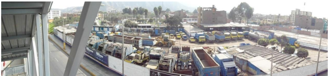
Figura N°81: Estación Pirámide del Sol del Metro de Lima tramo 2 Fuente: Propia
