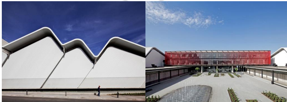
Figura N° 41: Vistas de las fachadas de la fábrica
