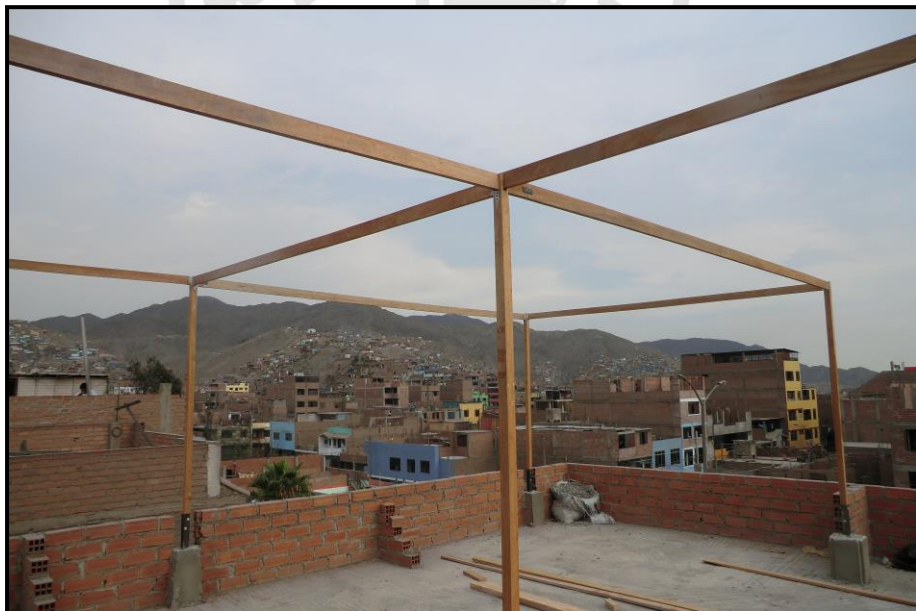
Figura 35: Estructura de módulo de producción hidropónica Fuente: Elaboración propia
