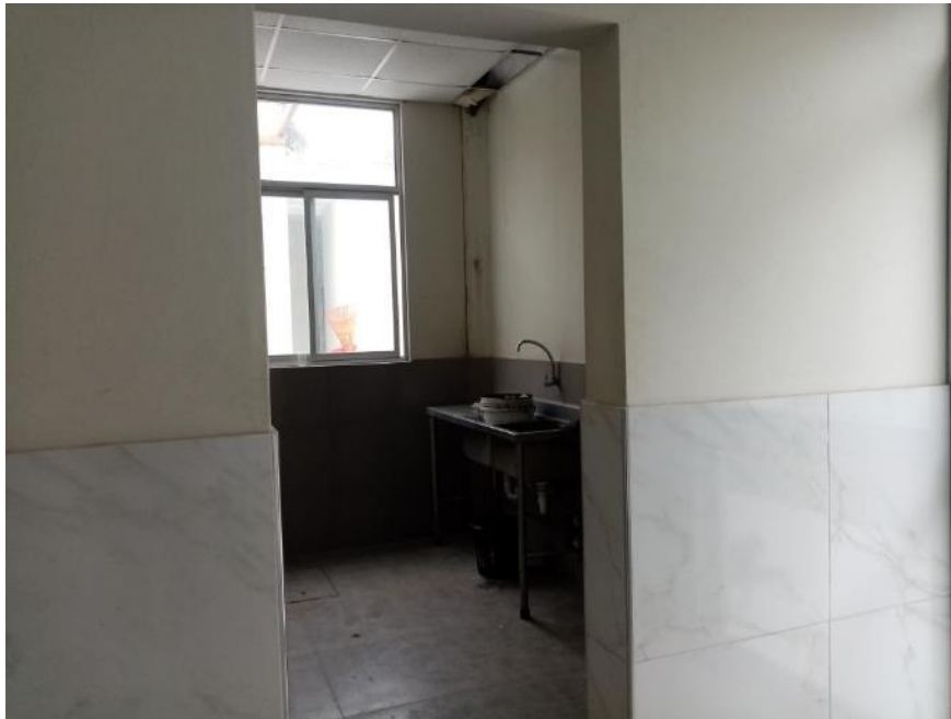
Figura 15 Interiores de las nuevas instalaciones asignadas al almacén.
