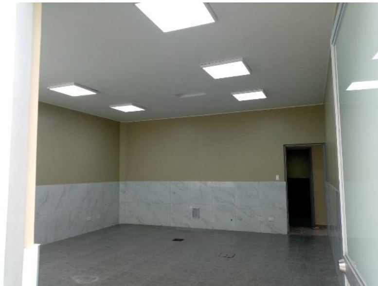
Figura 28 Trabajos de acondicionamiento de interiores terminados (ambiente de material de escritorio).
