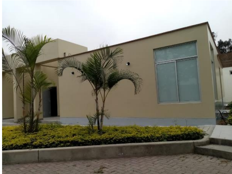
Figura 27 Trabajos de acondicionamiento de exteriores terminado.
