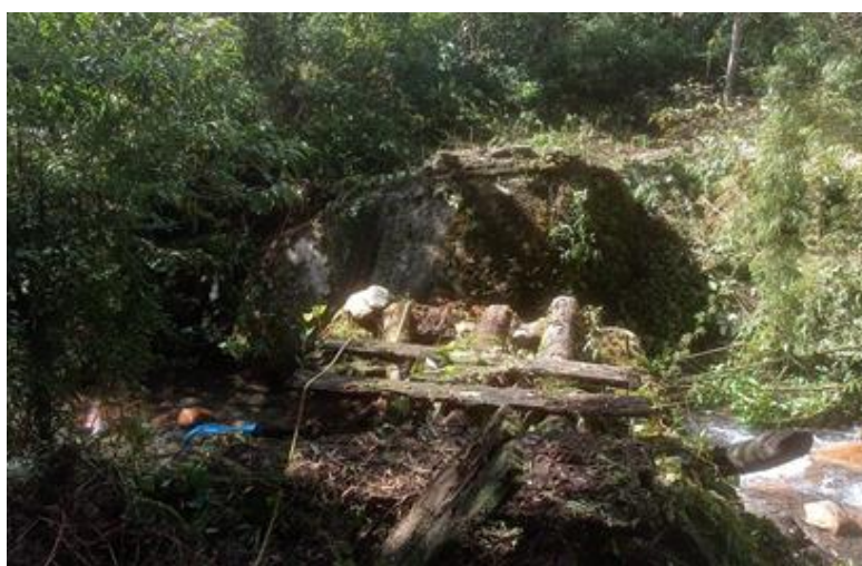
Puente Provisional existente en Quellomayo
