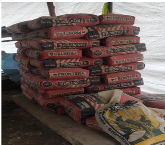
Transporte de materiales a la obra
