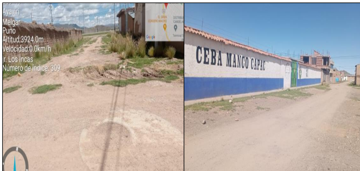
Figura 11 Estado actual del Jirón los Incas-Azángaro
