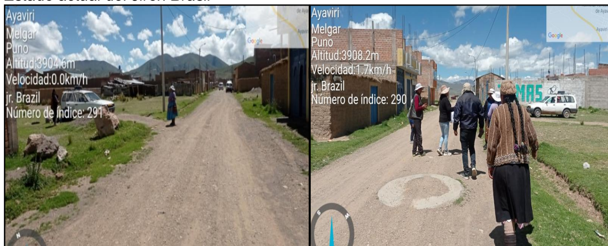
Estado actual del Jirón Brasil
