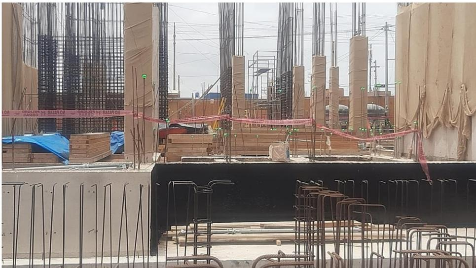
*Nota.* Se detalla la etapa de curado después de la ejecución de vaciado de concreto F'c 280 Kg/cm<sup>2</sup> de placas y columnas Adaptado de proyecto Centro de Salud, Gobierno Regional Moquegua, 2024.
