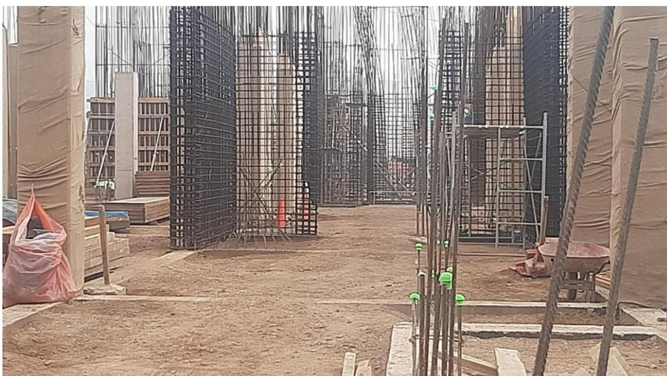
*Nota.* Se detalla la estructura del parte interior del sector A después de haber en la etapa de curado de concreto F'c 280 Kg/cm<sup>2</sup> de placas y columnas Adaptado de proyecto Centro de Salud, Gobierno Regional Moquegua, 2024.
