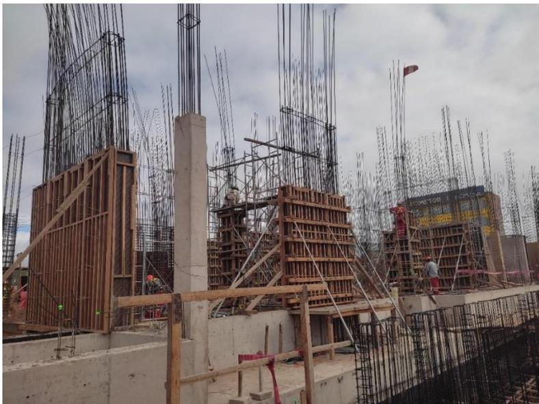
*Nota.* Se detalla la estructura del parte Final de sector A en la etapa de encofrado de placas y columnas Adaptado de proyecto Centro de Salud, Gobierno Regional Moquegua, 2024.
