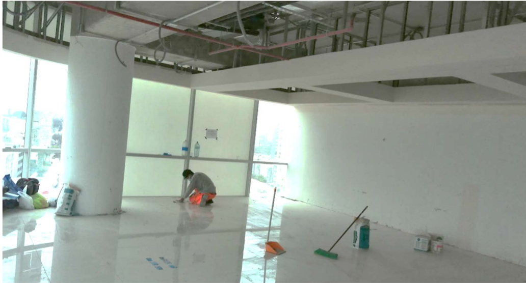
Figura 78. Instalación de piso de porcelanato, Obra: La Nuez.
