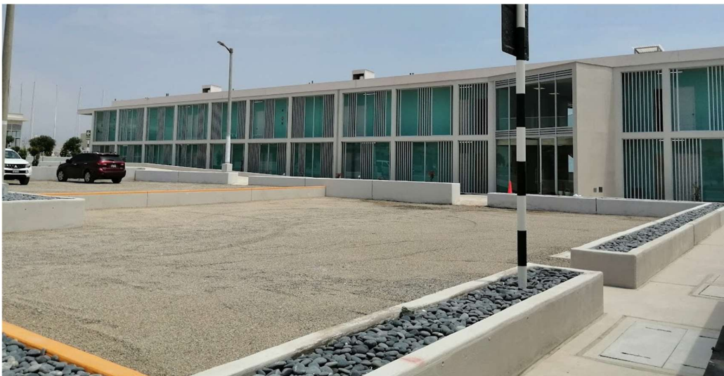
Figura 197. Estacionamientos y edificio Hospedaje, construcción culminada, Car Surf Punta Rocas.
