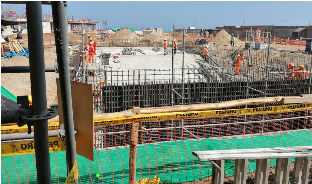
Figura 183. Piscina semiolímpica en construcción, Car Surf Punta Rocas.
