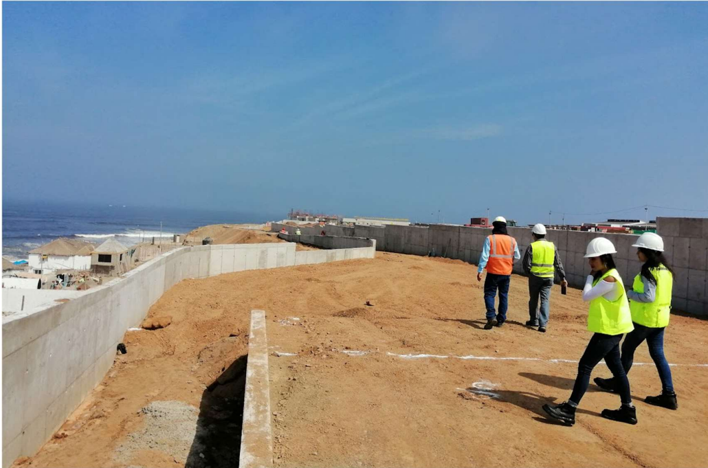
Figura 182. Paseo de la fama en construcción, Car Surf Punta Rocas.
