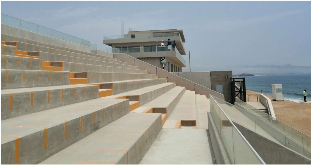
Figura 196. Tribuna de espectadores, construcción culminada, Car Surf Punta Rocas.
