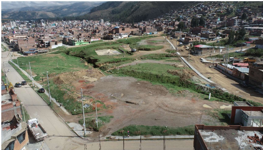
Figura 139. Vista aérea del terreno para el proyecto PCB – Huancayo.
