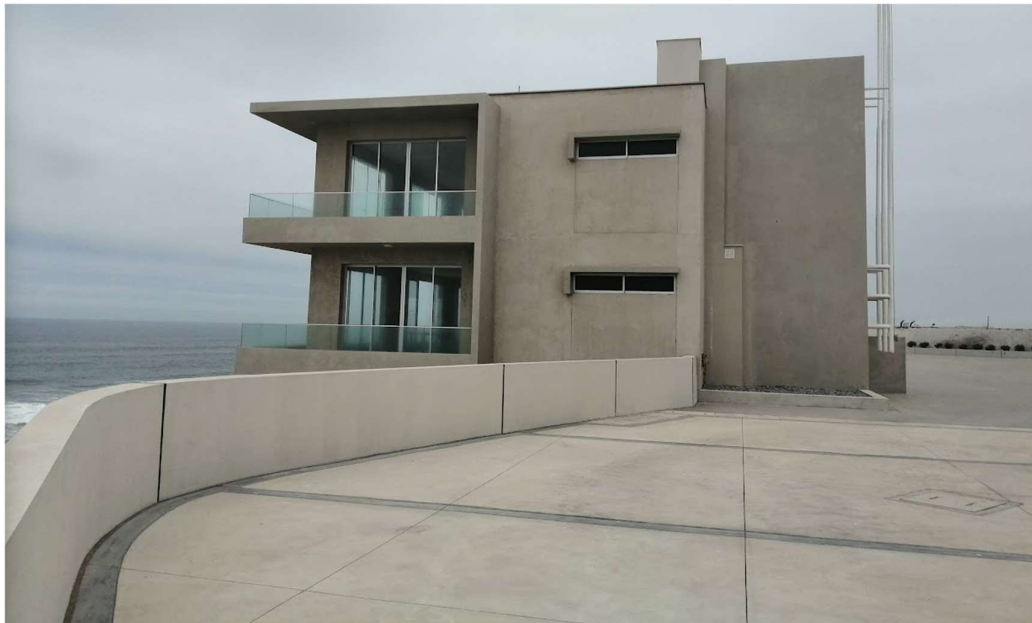
Figura 190. Edificio Jueces construcción culminada, Car Surf Punta Rocas.
