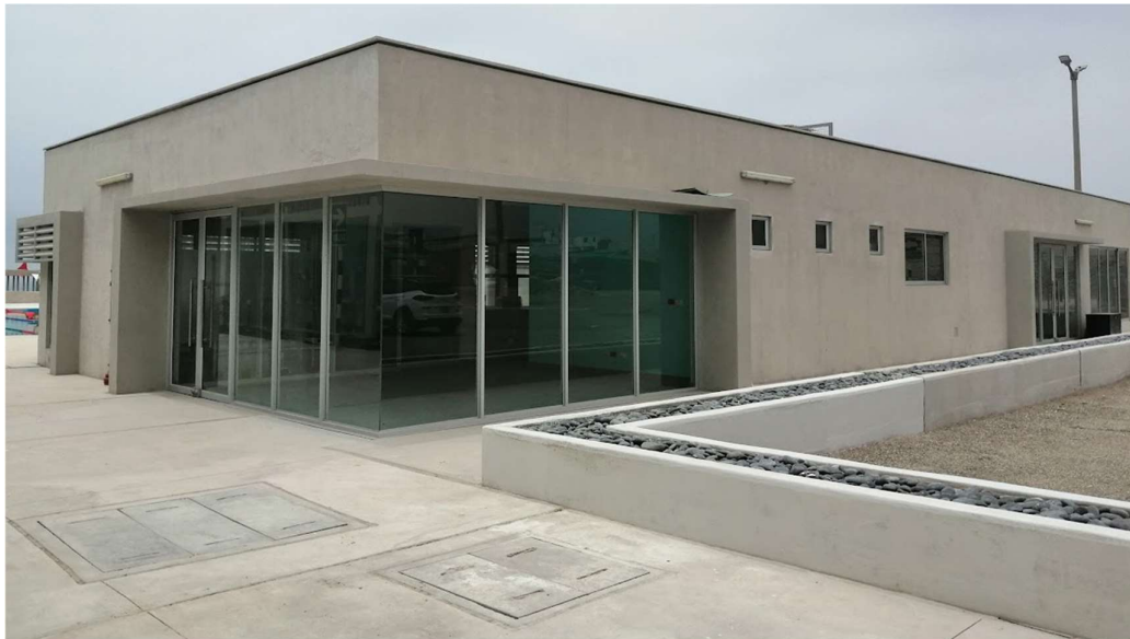
Figura 193. Edificio Administración, construcción culminada, Car Surf Punta Rocas.
