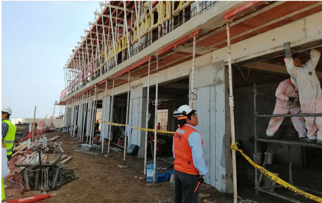
Figura 186. Edificio Jueces en construcción, Car Surf Punta Rocas.
