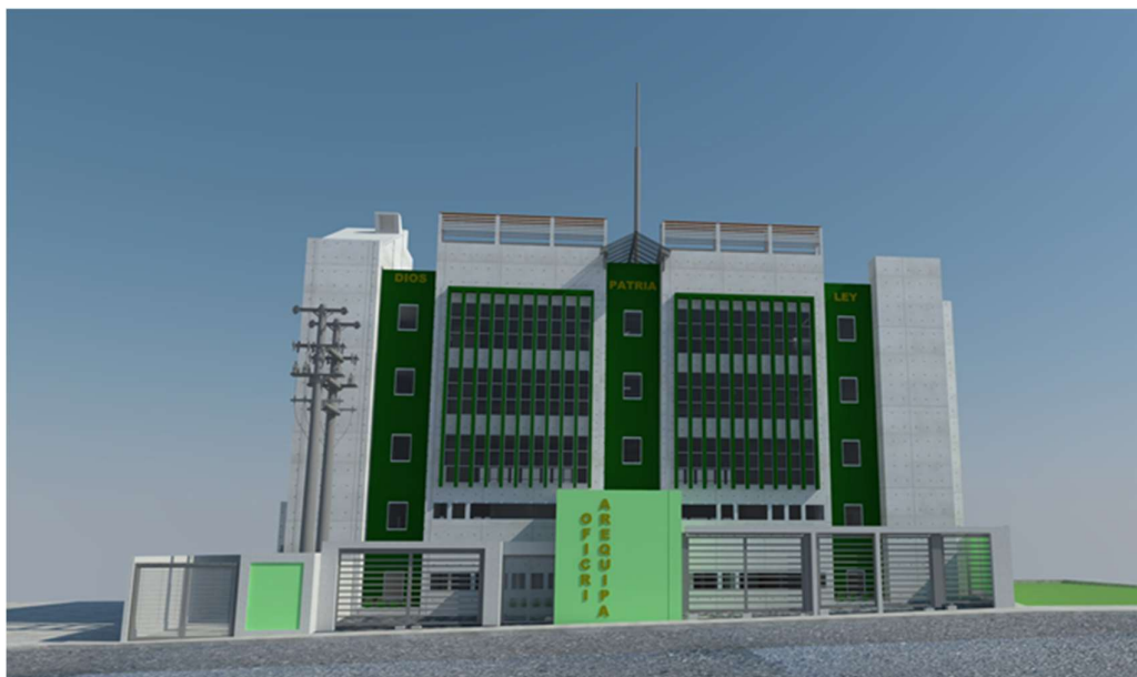
Figura 7. Vista del proyecto Oficinas de Criminalística - Arequipa
