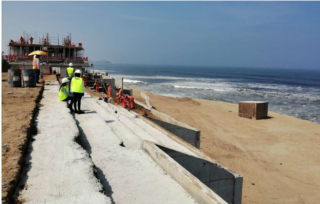
Figura 184. Tribuna de espectadores en construcción, Car Surf Punta Rocas
