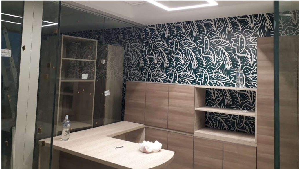
Figura 80. Instalación de mobiliario, Obra: La Nuez.
