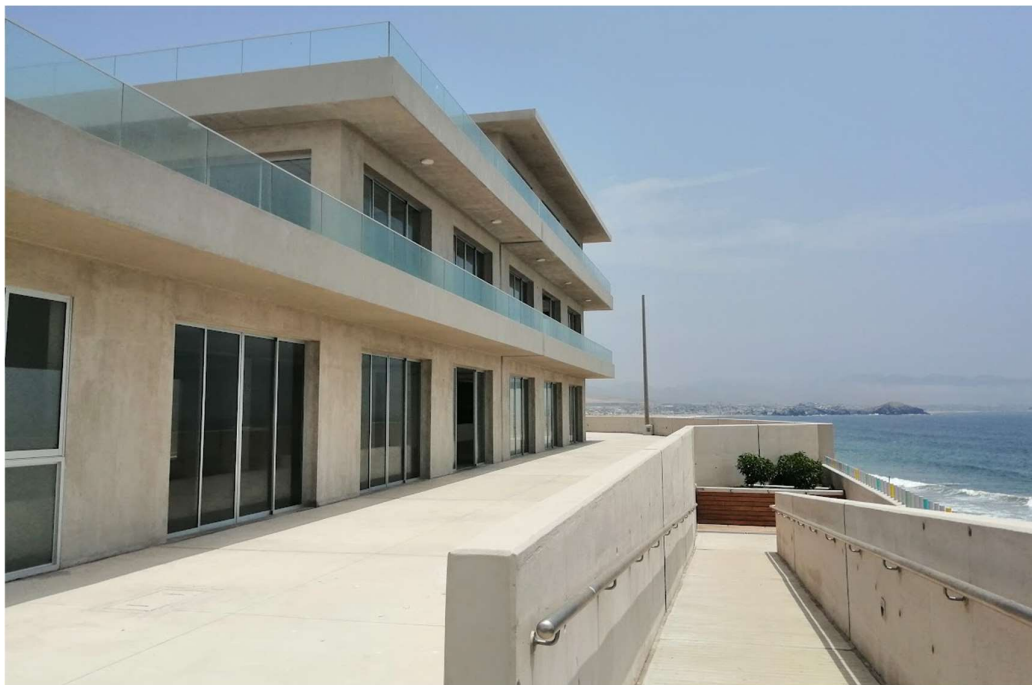
Figura 191. Edificio Jueces construcción culminada, Car Surf Punta Rocas.
