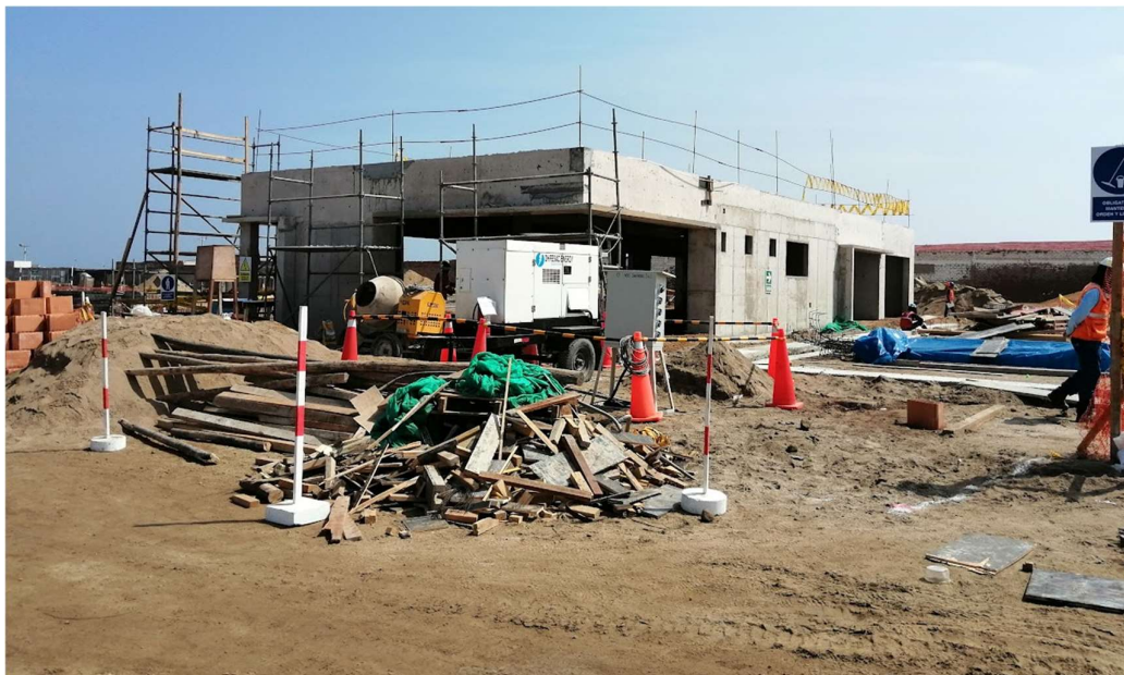
Nota. La figura muestra el edificio de administración en proceso de construcción. Fuente: Elaboración propia (2019).
