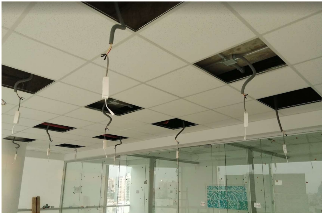
Figura 79. Instalación de luminarias, Obra: La Nuez.
