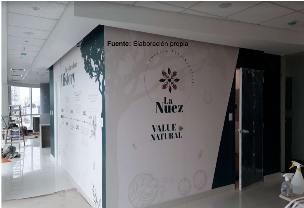
Figura 81. Instalación de viniles, Obra: La Nuez.
