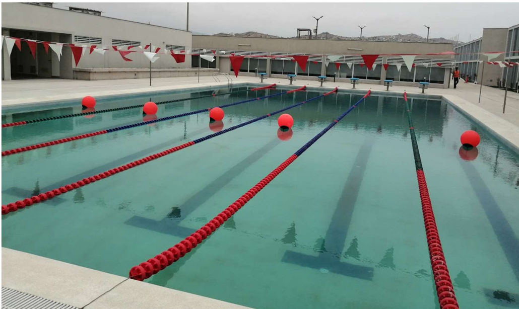
Figura 195. Piscina semiolímpica, construcción culminada, Car Surf Punta Rocas.
