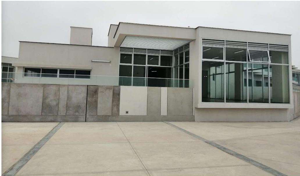
Figura 192. Cafetería – comedor construcción culminada, Car Surf Punta Rocas.
