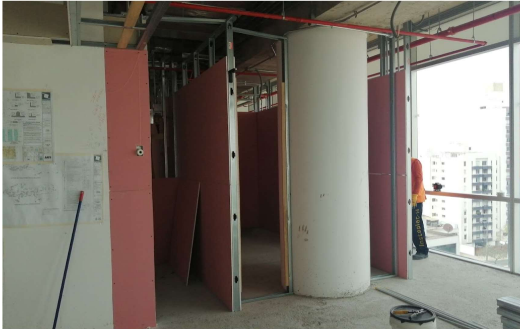
Figura 76. Instalación de tabiques de Drywall, Obra: La Nuez.
