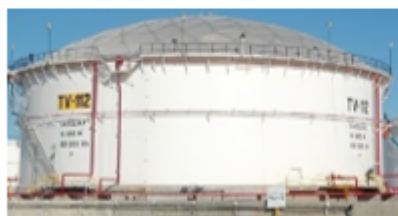
Figura 1: Tanque de almacenamiento 1
