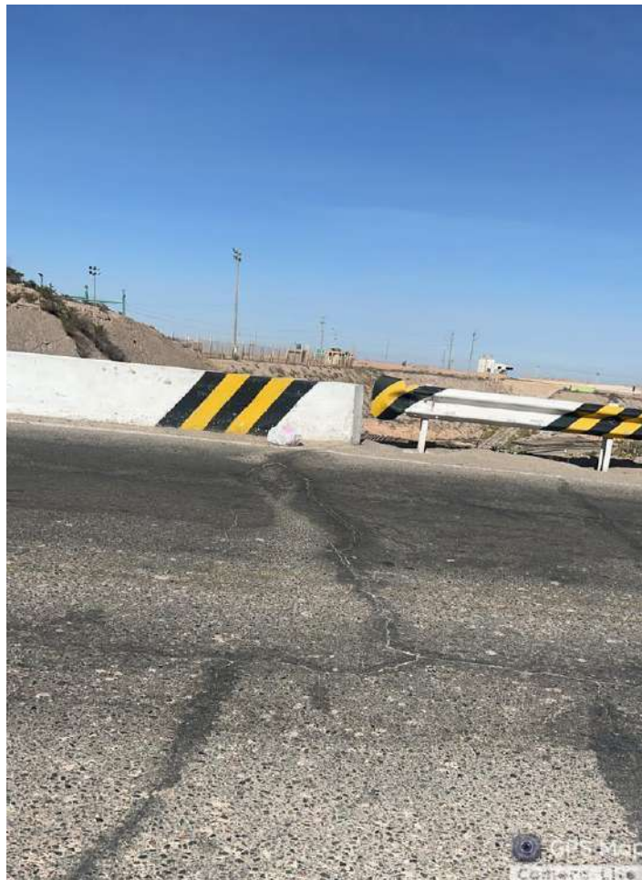
Figura 12. Descaramiento.
