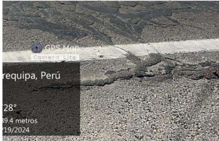
Figura 5. Fisuras Longitudinales
