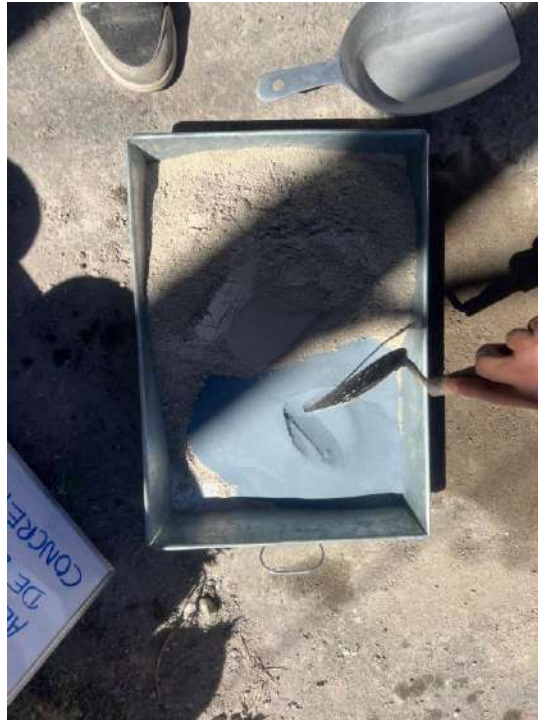
Figura 69. Mezcla de cemento con geopolímero
