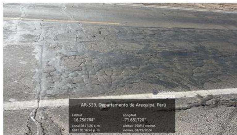
Figura 5. Fisuras Transversales
