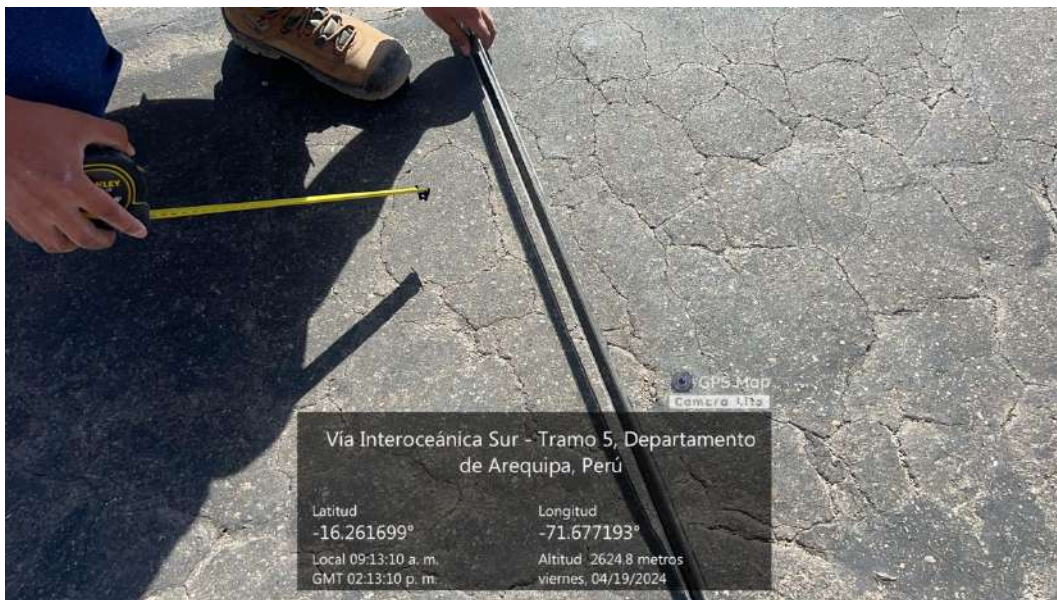
Figura 9. Ahuellamiento.
