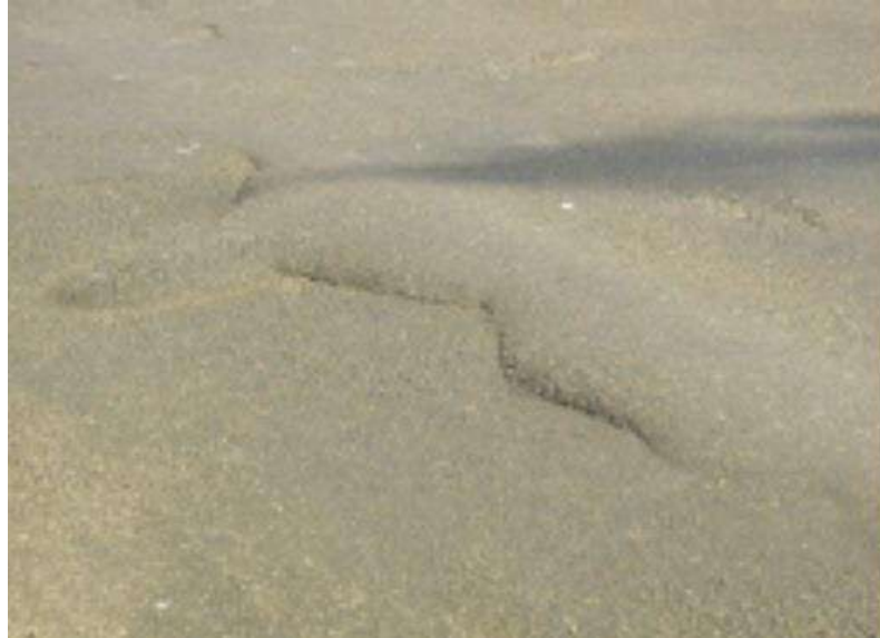
Figura 11 Ondulación.
