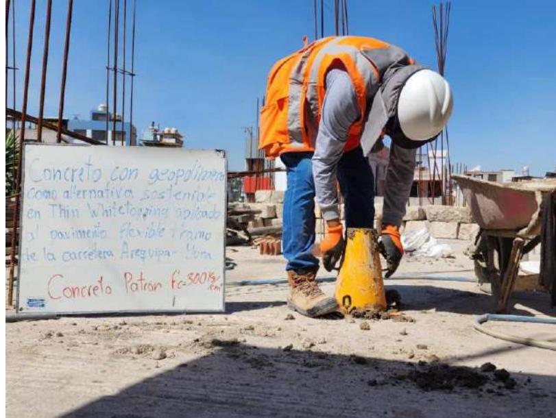
Figura 65. Retiro del cono de Abrahams
