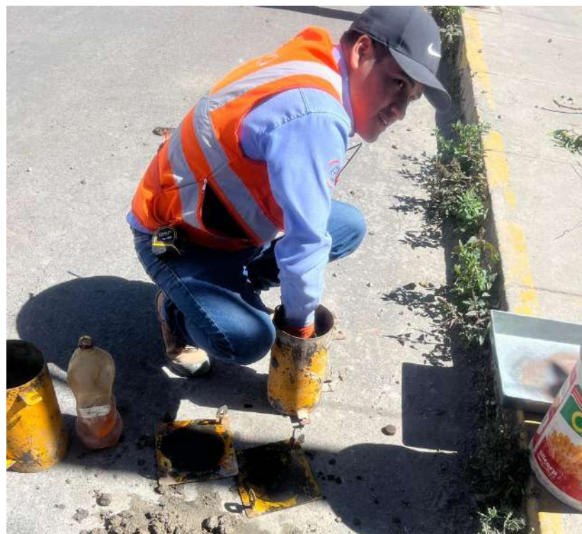
Figura 71. Proceso de limpieza y recubrimiento de petróleo de los moldes
