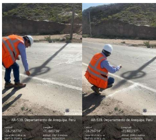
Figura 43. Seccionamiento cada 40.00 metros
