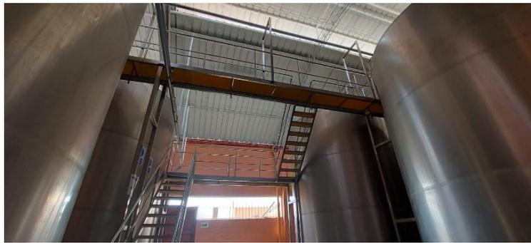
*Nota: Se aprecia la pasarela de acero inoxidable con acabado cepillado, es una construcción robusta totalmente soldada, según los datos proporcionados por la sommelier, la estructura puede soportar hasta cinco toneladas de soporte por cada planta.*
