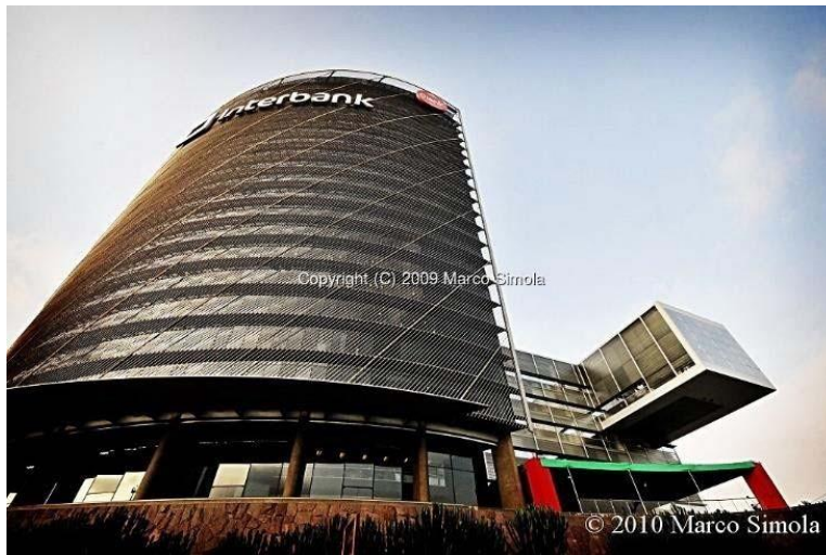
Figura N° 11: Edificación La Torre de Interbank
