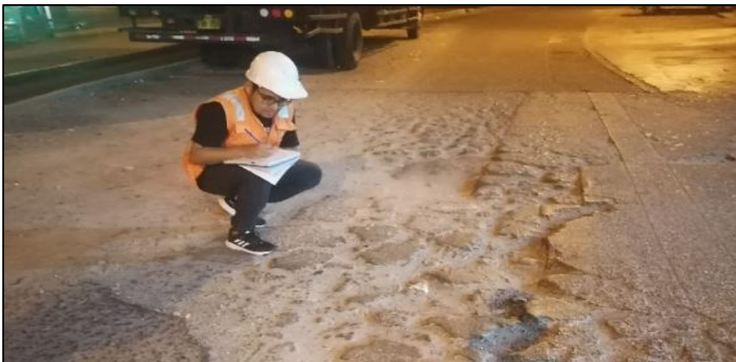
Figura 50. Medición de fallas
