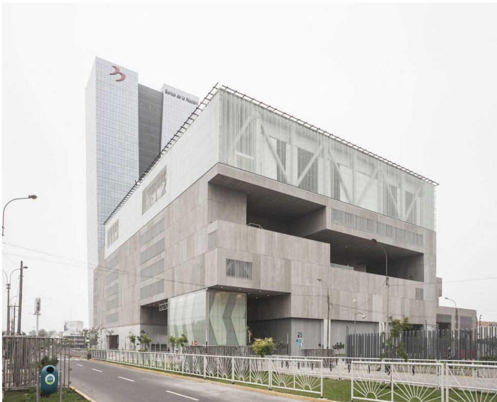
Figura 1. Vista Fachada Principal Centro de Convenciones de Lima
