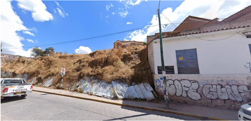
Figura 47. Vista de Av. Arcopata
