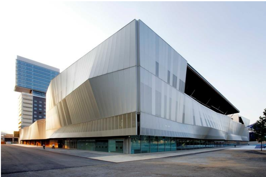
Figura 9. Vista Fachada Principal Centro Cultural Internacional de Barcelona
