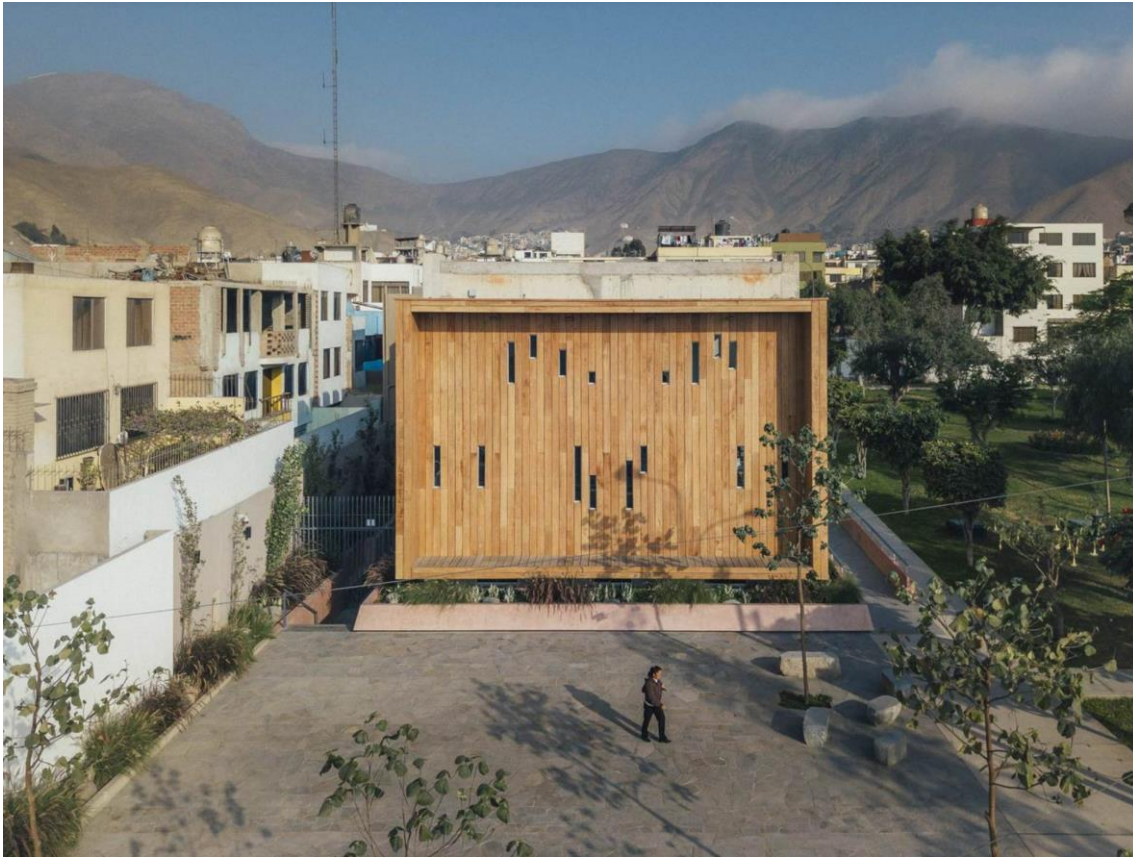
Figura 3. Vista Fachada Principal Biblioteca Comunitaria
