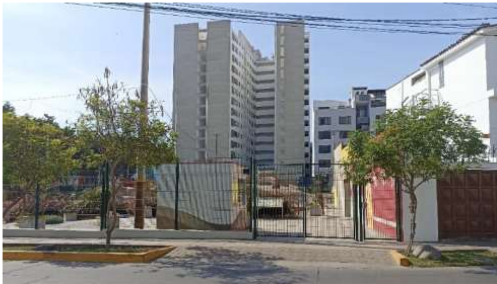
Vista del exterior de la Huaca La Merced
