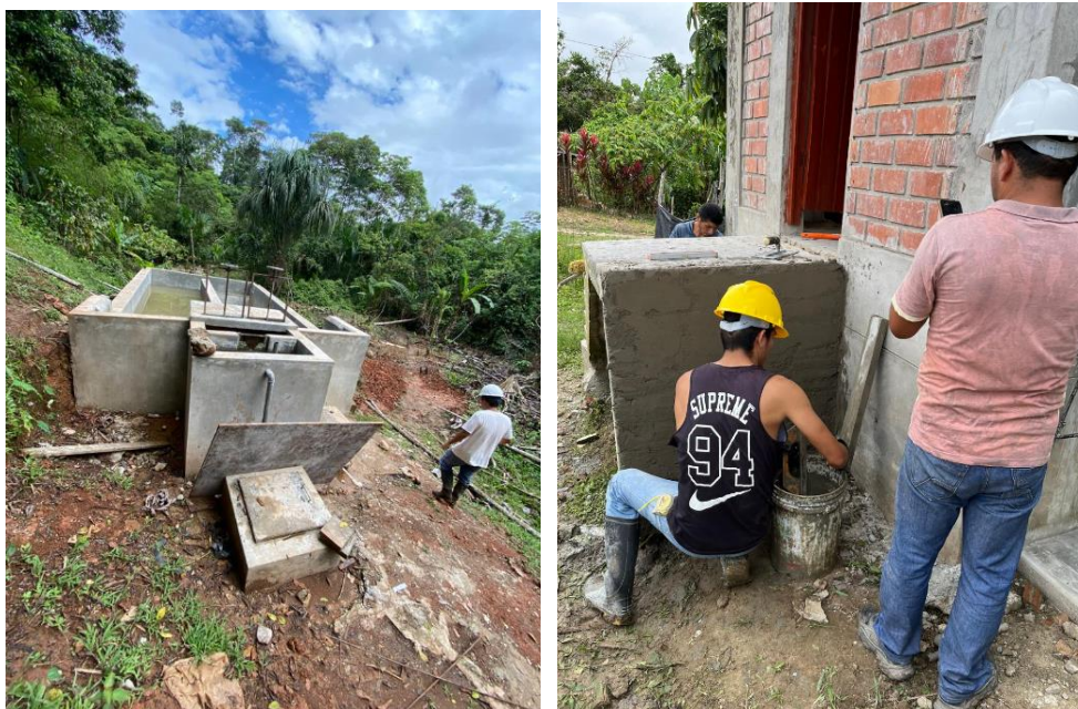
Figura24 Tarrajeo del Sedimentador y UBS
