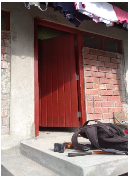
Figura26 Instalacion de Puertas y Techos
