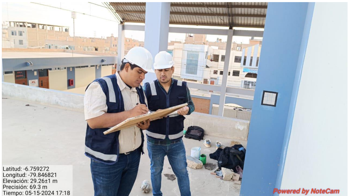
Figura 38. Esclerometría en sección irregular.
