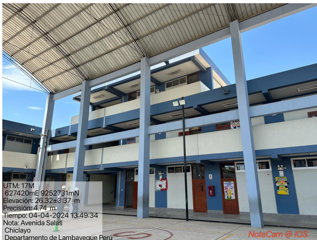
Figura 48. Toma del pabellón irregular de la I.E. N°10924
