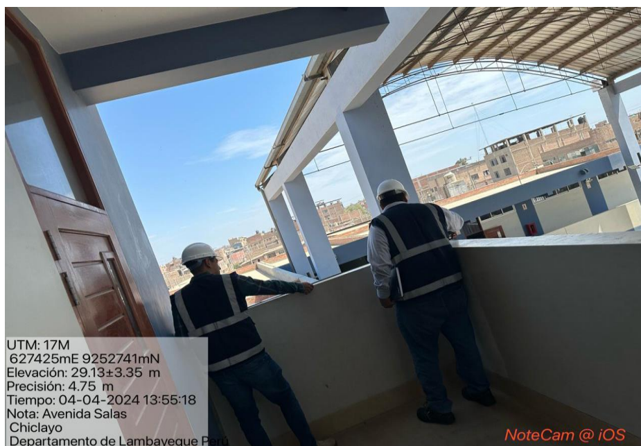
Figura 26. Toma de medidas en zonas colindantes
