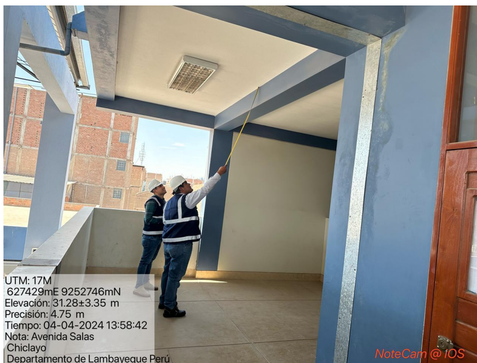
Figura 53. Toma de datos de vigas peraltadas en la muestra
