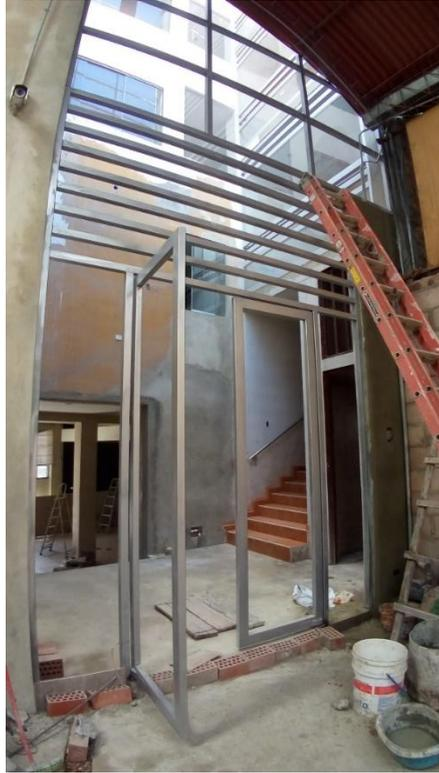
**Figura 19:** Proceso de construcción – acabados falso cielo raso en recepción.
