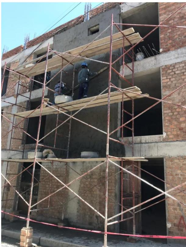
**Figura 48:** Proceso de construcción – tarrajeo en fachada principal.
