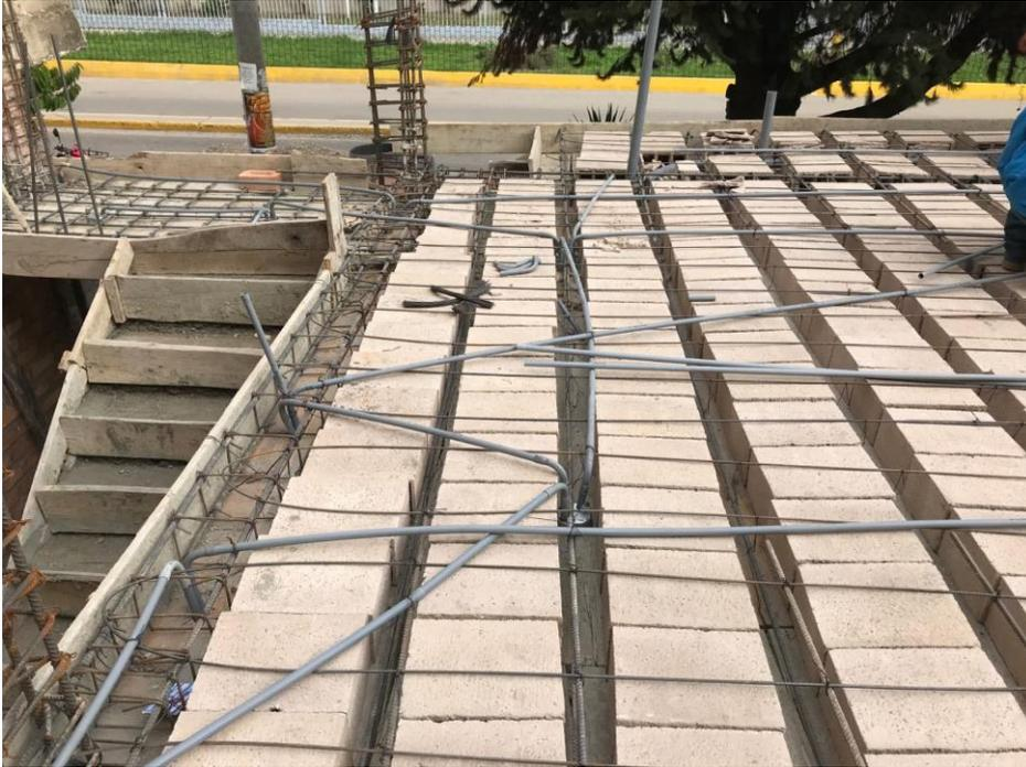
**Figura 25:** Proceso de construcción – acero en vigas y losa aligerada.
