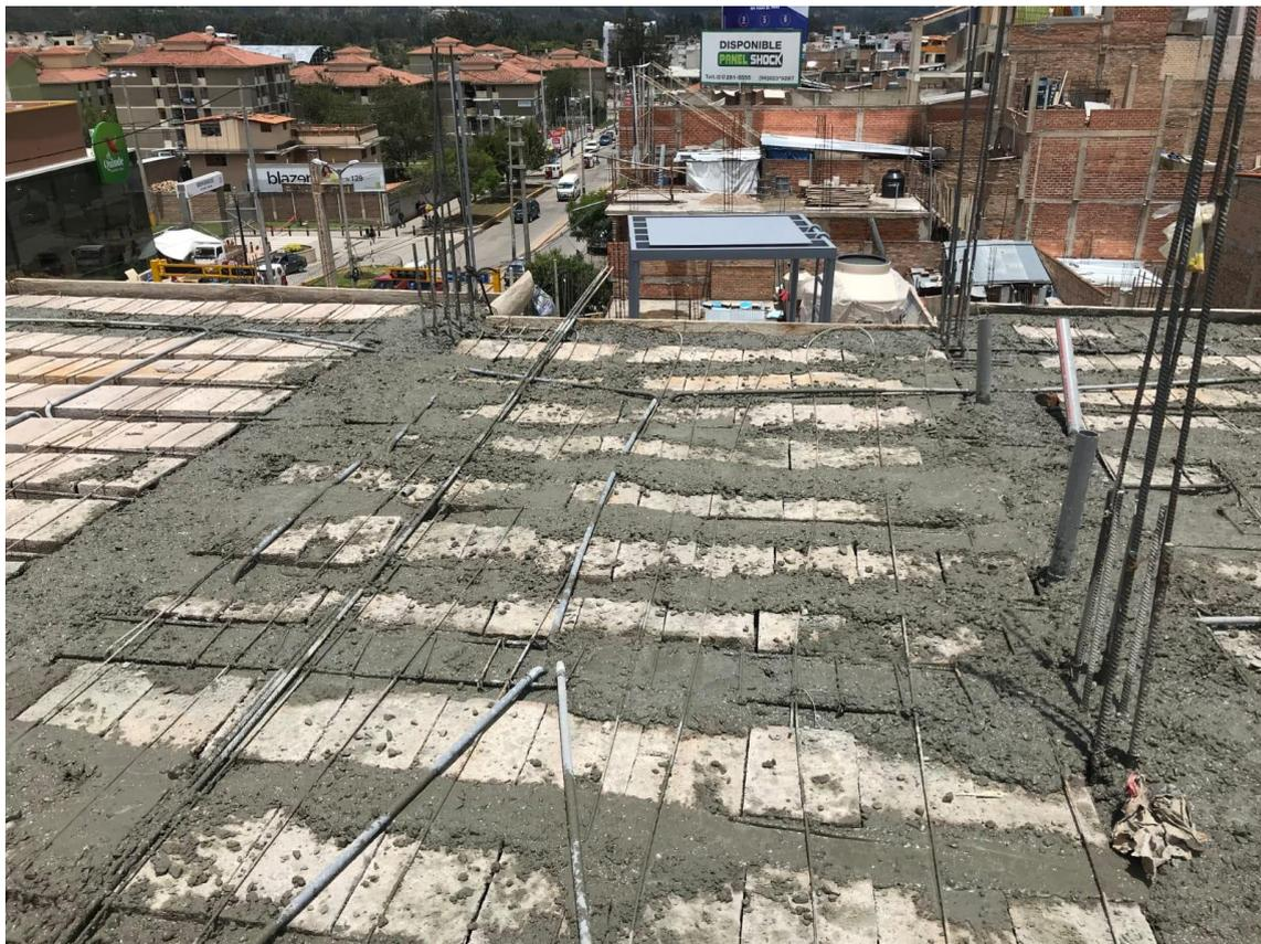
**Figura 28:** Proceso de construcción – concreto en losa aligerada.
