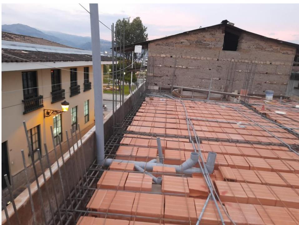
**Figura 46:** Proceso de construcción – concreto en losa aligerada.
