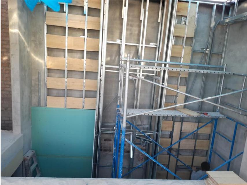
**Figura 37:** Proceso de construcción – falso cielo raso en área de mesas.
