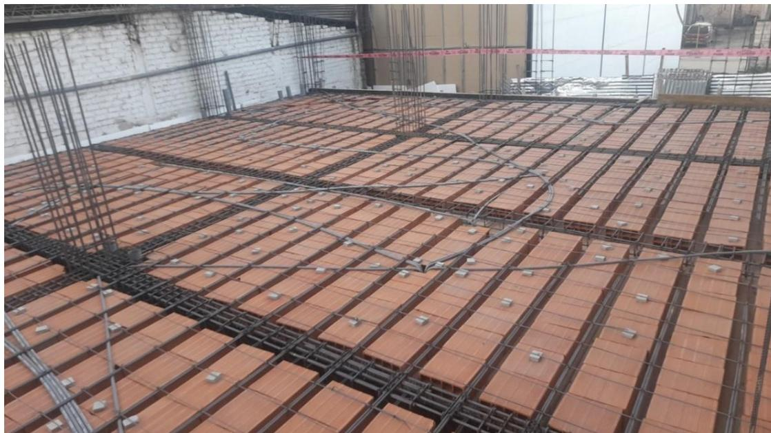
**Figura 69:** Proceso de construcción – Acero en vigas.
