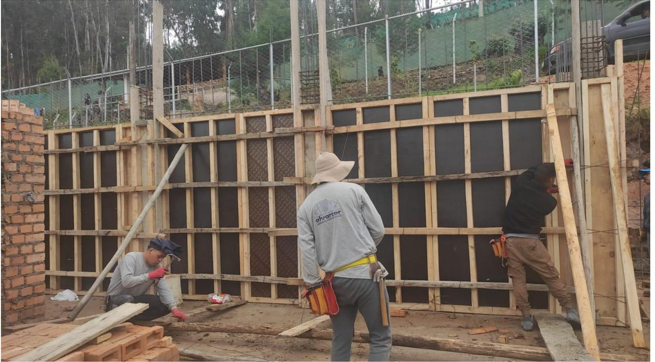
**Figura 57:** Proceso de construcción – Losa aligerada
