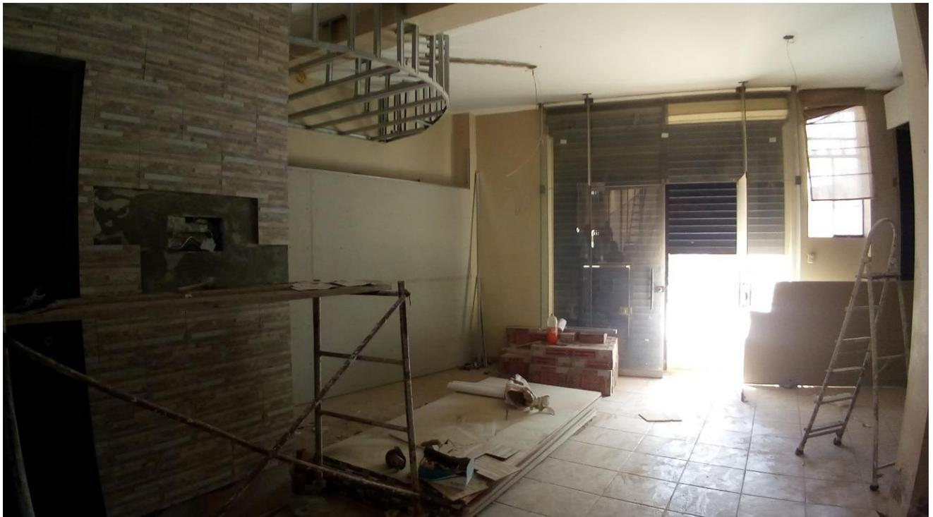
**Figura 20:** Proceso de construcción – acabados falso cielo raso en sala de espera.
