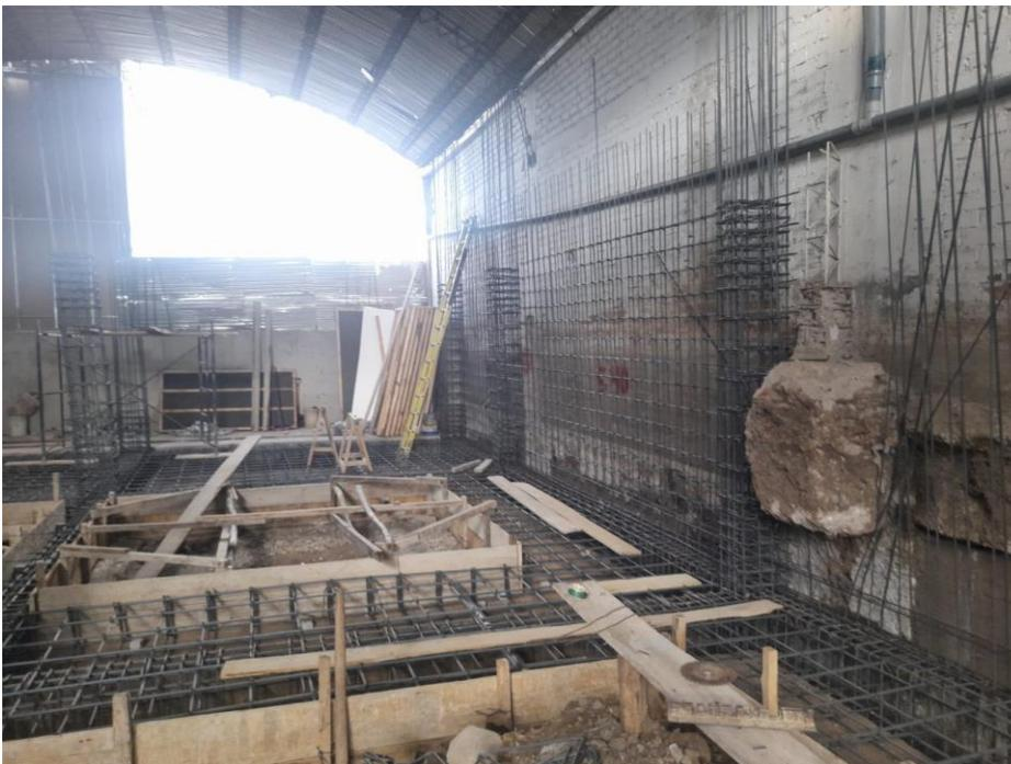
**Figura 68:** Proceso de construcción – Acero en Losa aligerada de sótano.
