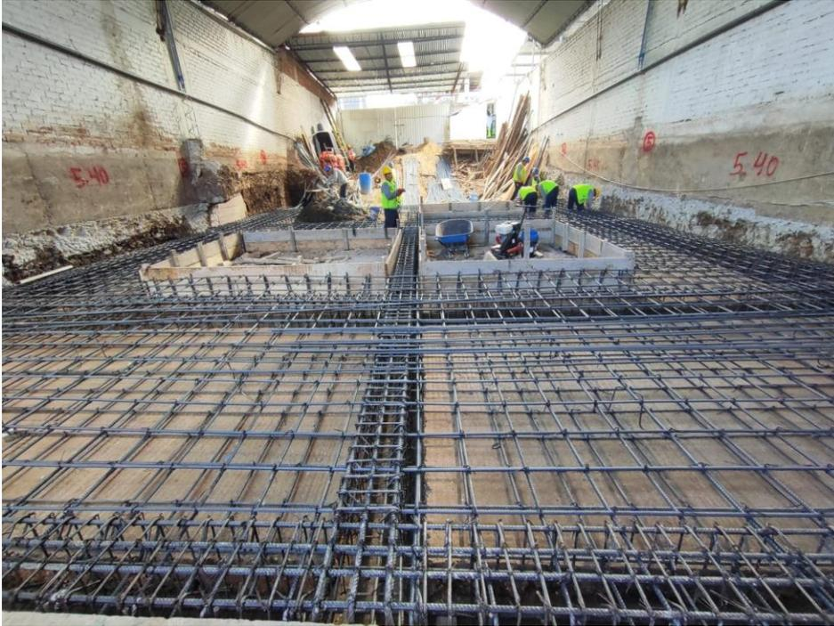
**Figura 67:** Proceso de construcción – Acero en muros de contención.
