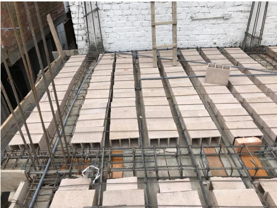
**Figura 26:** Proceso de construcción – concreto en vigas.
