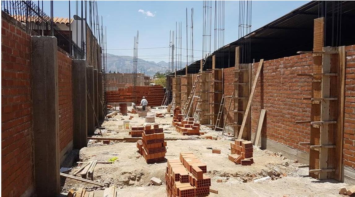
**Figura 07:** Proceso de construcción de primer nivel – encofrado de vigas.
