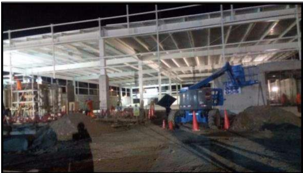
Figura 184: Vista interior de Obra-2
