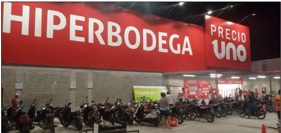
Figura 81: Fotografía interna- Estacionamiento.
