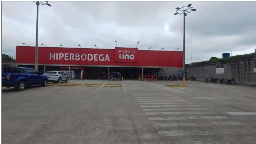
Figura 104: Fotografía Interna Fachada - Iquitos La Marina
