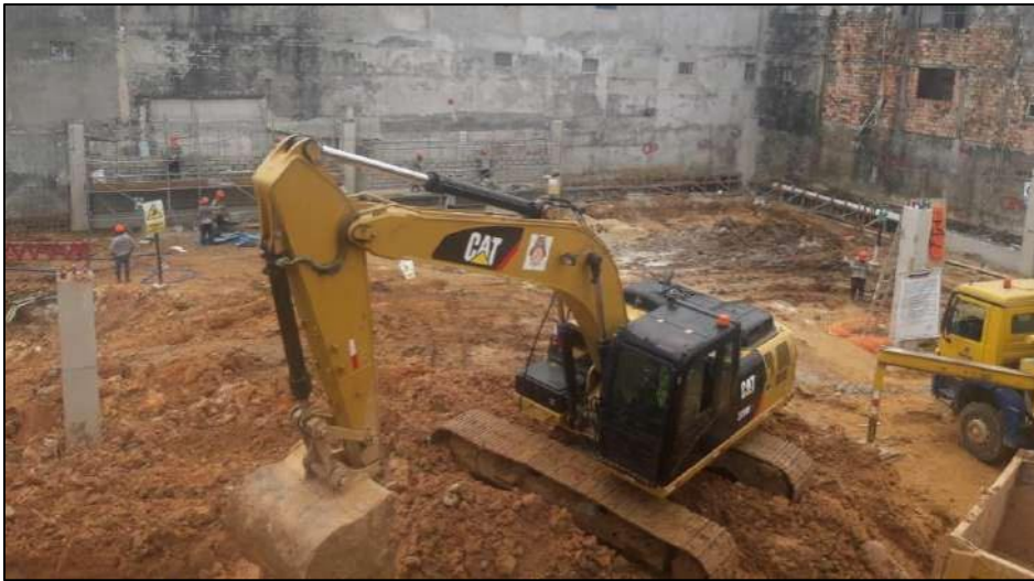
Figura 74: Fotografía inicio de obra
