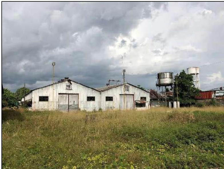
Figura 101: Fotografía en el terreno-1 - Iquitos La Marina
