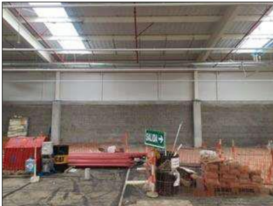
Figura 103: Fotografía Obra - Iquitos La Marina
