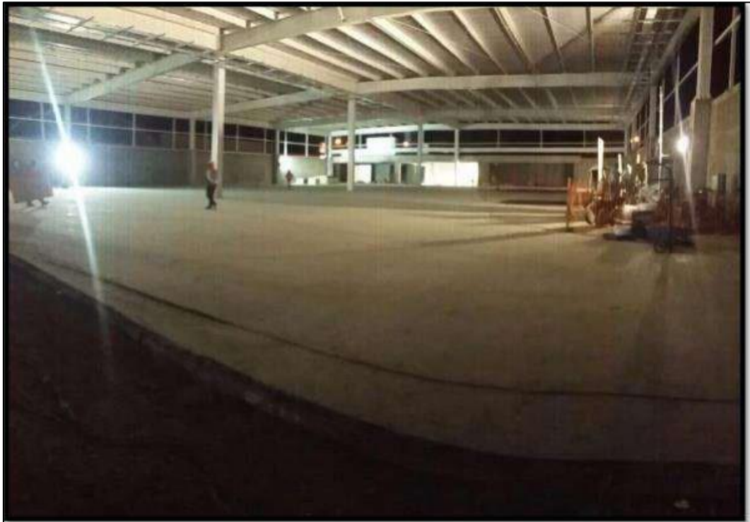
Figura 183: Vista interior de Obra-1
