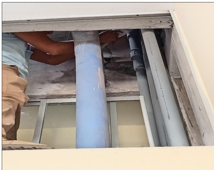
Figura 32 Instalación Cajas de Paso
