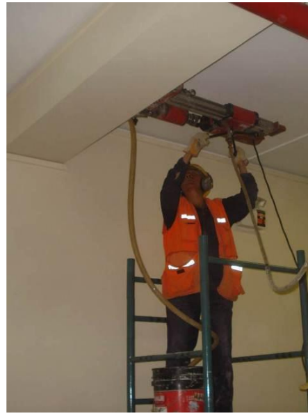
Figura 1.7 Extracción de testigos en vigas
