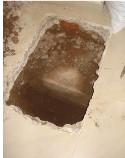
Figura 1.9 Revisión de zapatas existente
