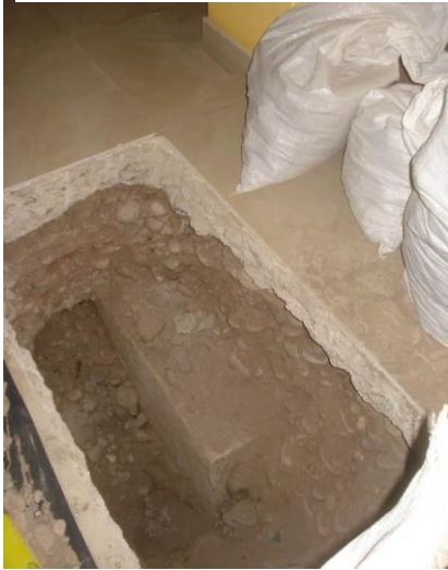
Figura 1.8 Revisión de zapatas existente
