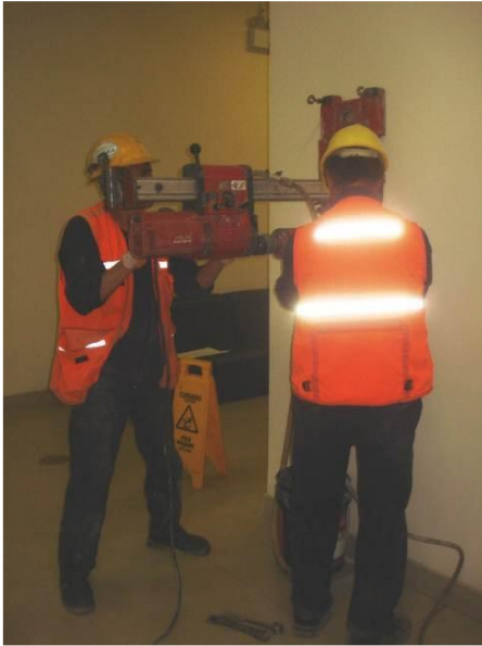
Figura 1.6 Extracción de testigos en columnas
