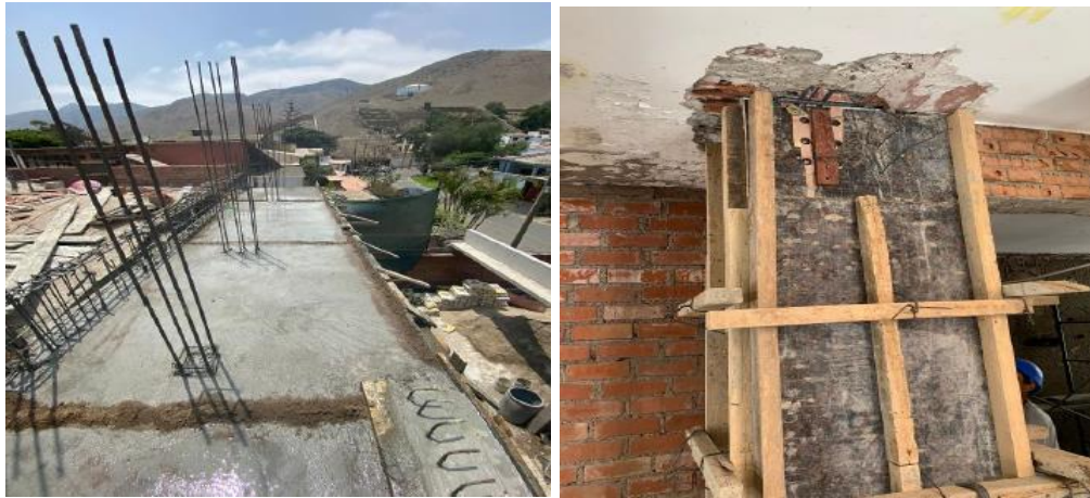
Figura 29. Habilitación de acero y encofrado de elementos estructurales Recuperado de proyecto de vivienda unifamiliar.
