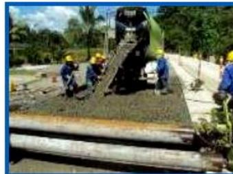
Figura 2: Colocación de hormigón
