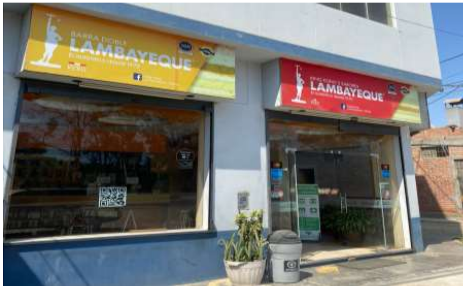
Fachada ingreso Empresa King Kong Lambayeque
