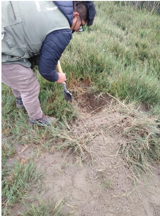
Figura 3. Excavación para el vaceado del dado de concreto.
