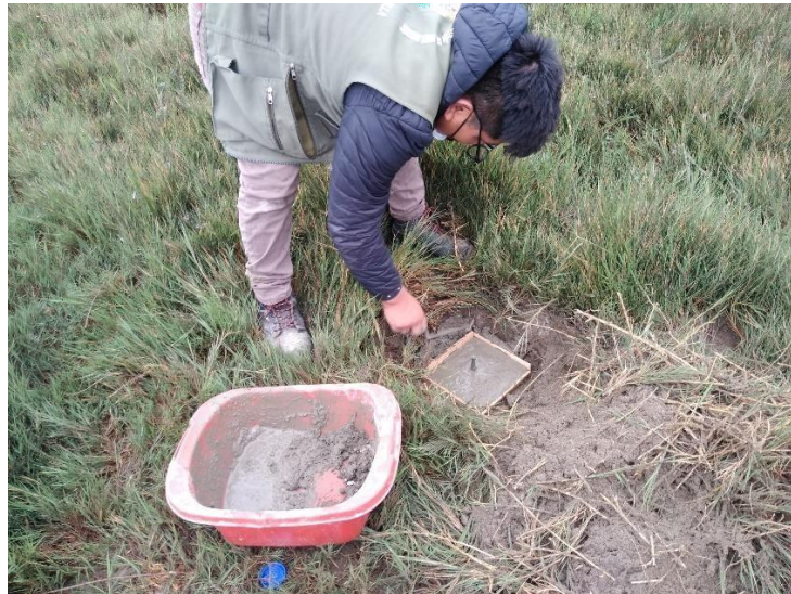
Figura 4. Vaceado de concreto sobre el dado.
