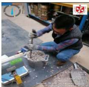
FOTO N°22 PESO UNITARIO DEL AGREGADO GRUESO
