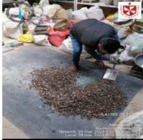
FOTO N°13 MEZCLADO DEL AGREGADO GRUESO
