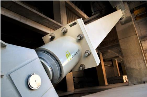
Disipador Fluido Viscoso
