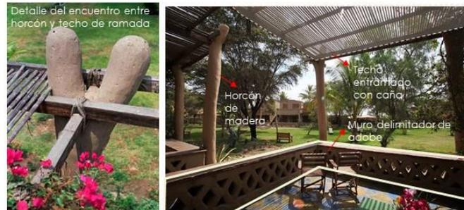
En los ciemientos se hicieron de piedra, los muros son de adobe, la quincha en algunos muros, así como también en los techos y entrepisos, con quincha reforzadas (mallas y cemento), la madera de algarrobo se usó como vigas y columnas, el eucalipto en mobiliario y carpintería.
