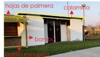
Para las otras áreas: cocina, SS.HH, caja-bar, almacén, el sistema constructivo empleado es el convencional, con material noble, y el techo tienen como cubierta calamina metálica
