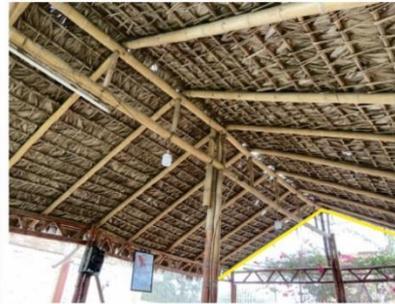
Techo a 2 aguas con un sistema constructivo de tijerales de bambú
