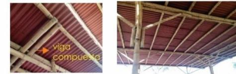
La estructura ecoamigable tiene como cerramiento a un techo de polipropileno color rojo.
