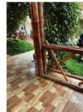
En las barandas han colocado 2 varillas de bambú de 2" con corte recto y 2 varillas de pasamano amarrando la estructura
