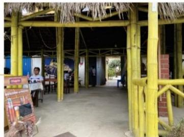
La parte frontal de la edificación es de materiales rústicos de la zona, le han dado color a la estructura de bambú y el techo tiene doble altura en la parte céntrica. La cubierta es de hojas de palmera tejida
