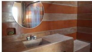
En los baños se usó ladrillo y concreto. Los ladrillos pasteleros en acabados de pisos, entrepisos y zócalos, también se utilizó el cemento coloreado
