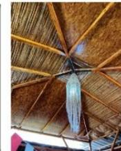
techo a 4 aguas, 2 con cerramiento OSB y los otros 2 con cerramiento de cañas horizontales, estructura de madera
