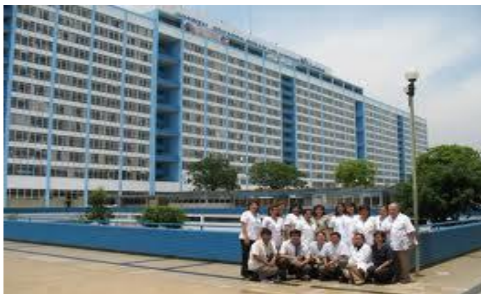
Figura 12 Hospital Edgardo Rebagliati
