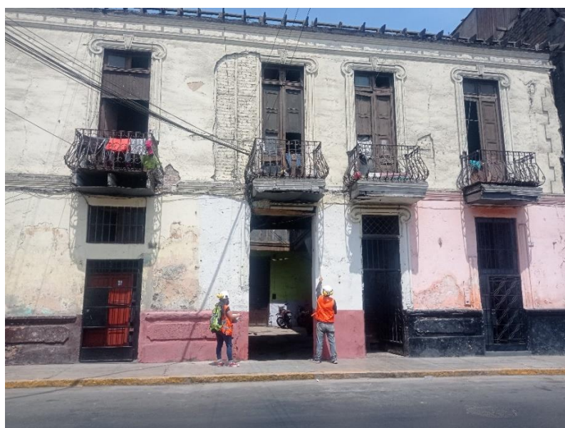
Fotografía tomada por el autor
