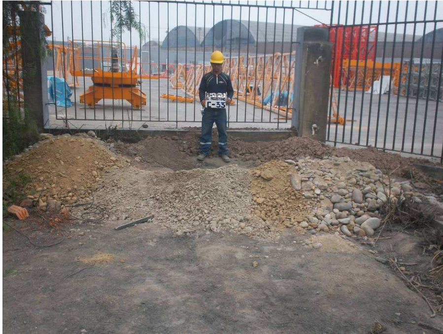
UBICACIÓN DE LA CALICATA C-33.
