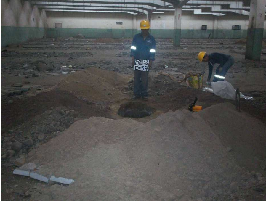
UBICACIÓN DE LA CALICATA C-57.
