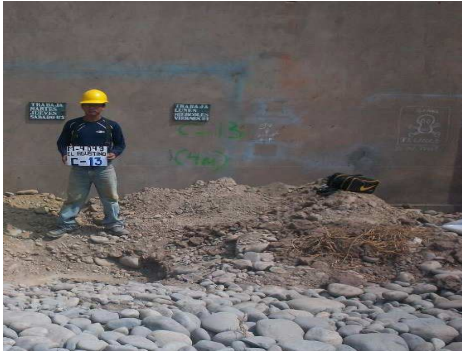
UBICACIÓN DE LA CALICATA C-13.
