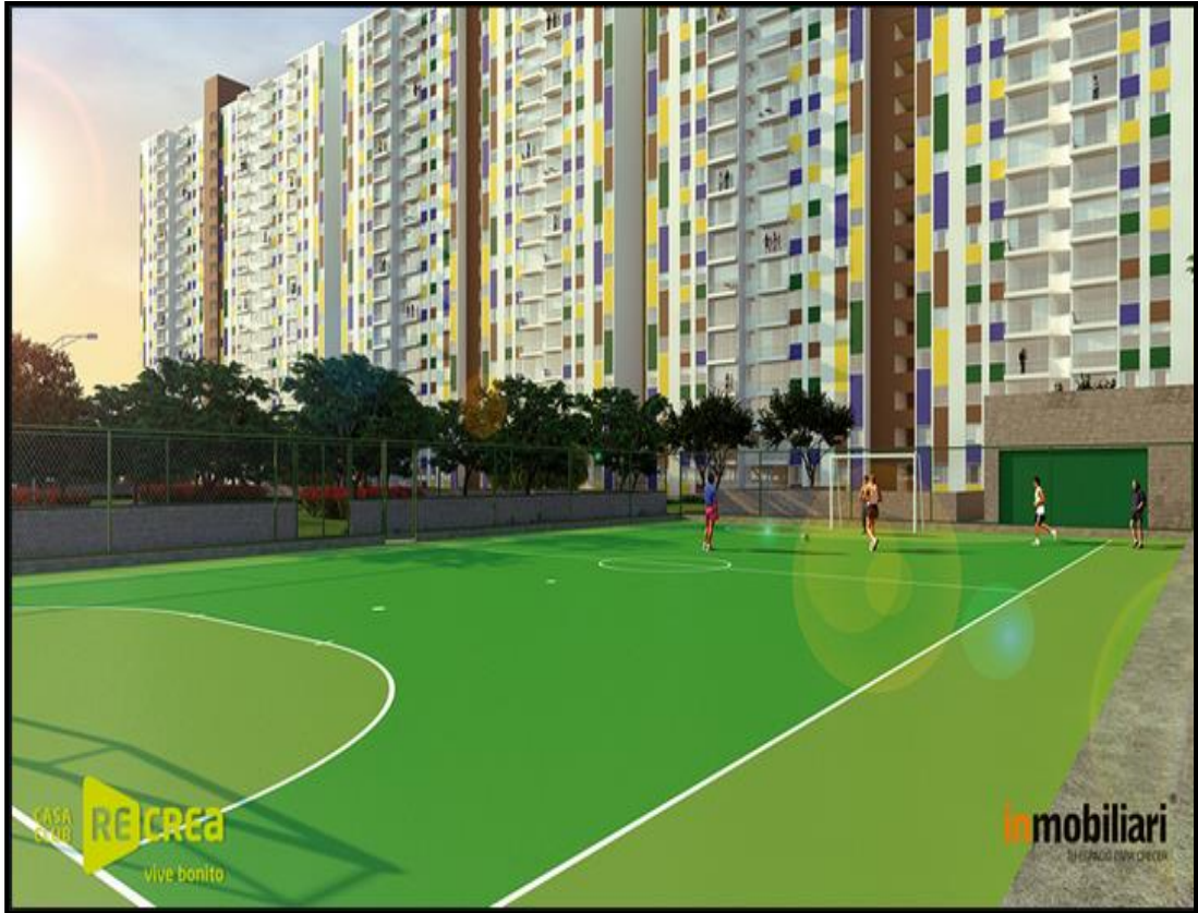
Imagen No 12: Prototipo de Obra finalizada
