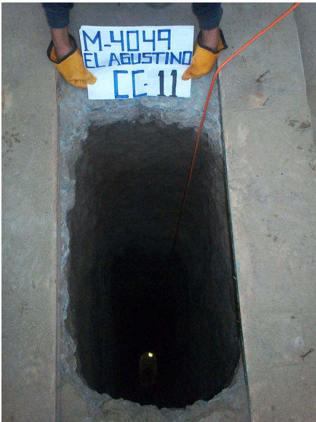
VISTA HACIA EL INTERIOR DE LA CALICATA CC-11.
