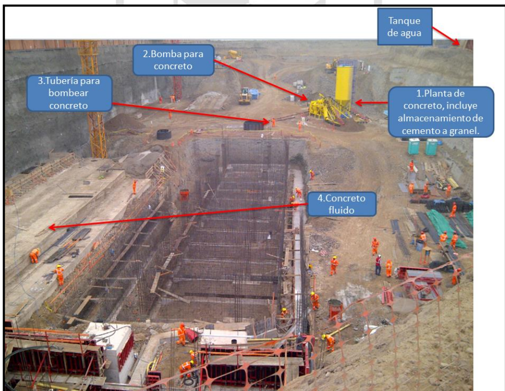
Imagen No 15: Ubicación de equipos para vaciado de concreto fluido
