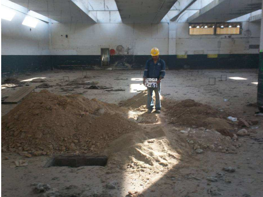
UBICACIÓN DE LA CALICATA C-61.
