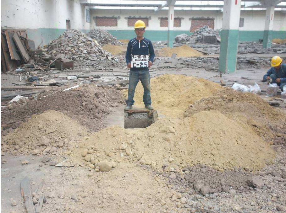
UBICACIÓN DE LA CALICATA C-25.
