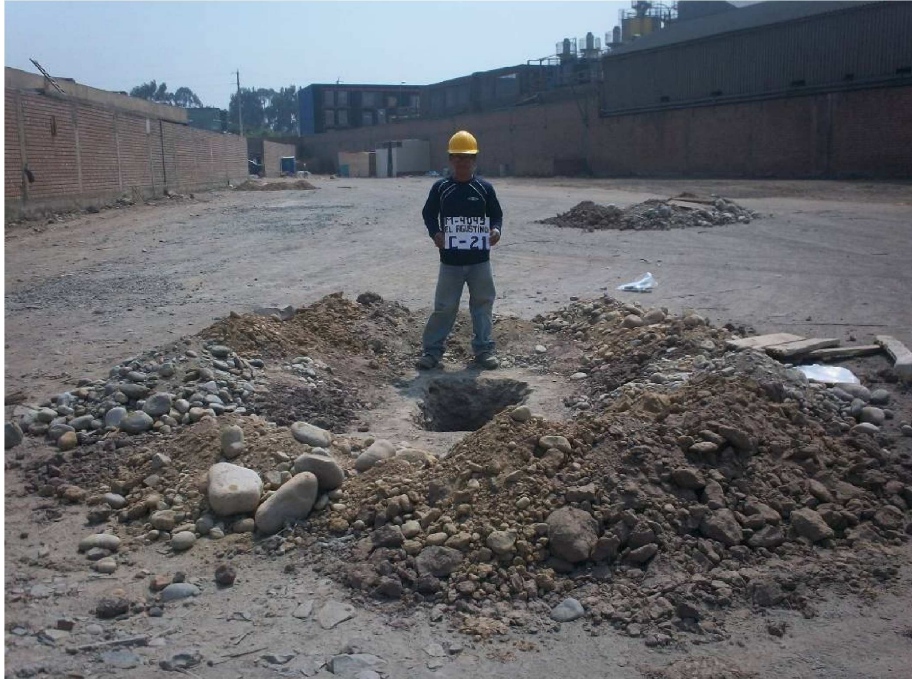
UBICACIÓN DE LA CALICATA C-21.
