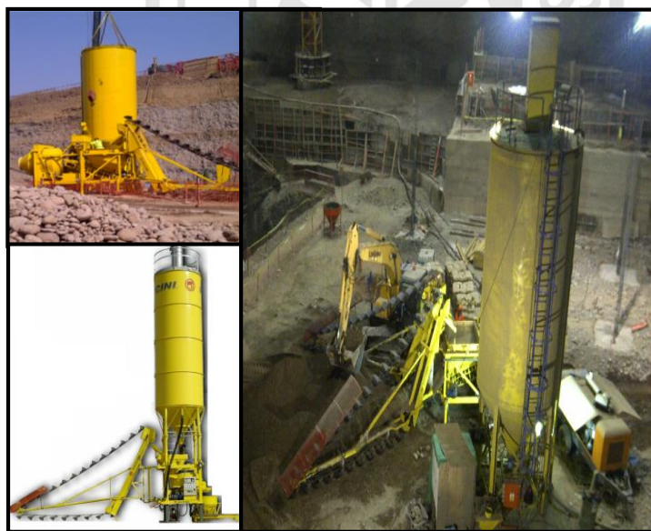
Imagen No 13: Planta dosificadora de concreto Piccini en obra
