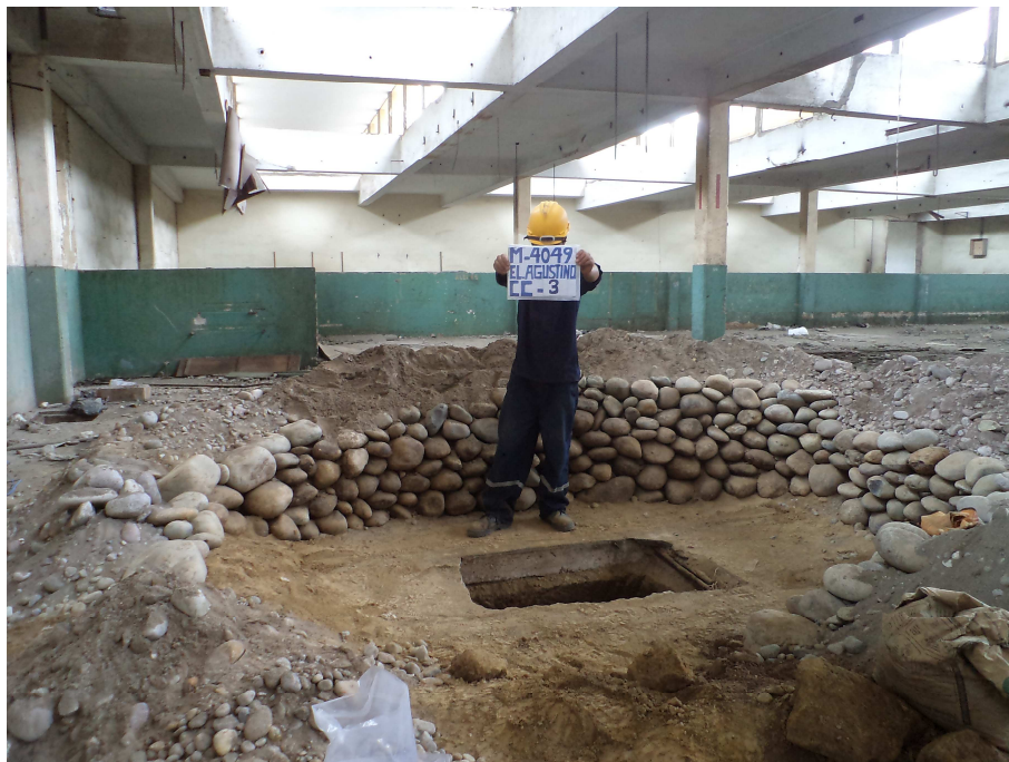
UBICACIÓN DE LA CALICATA CC-3. SE APRECIAN LAS PIEDRAS Y BOLONES EXTRAIDOS DE LA EXCAVACION.
