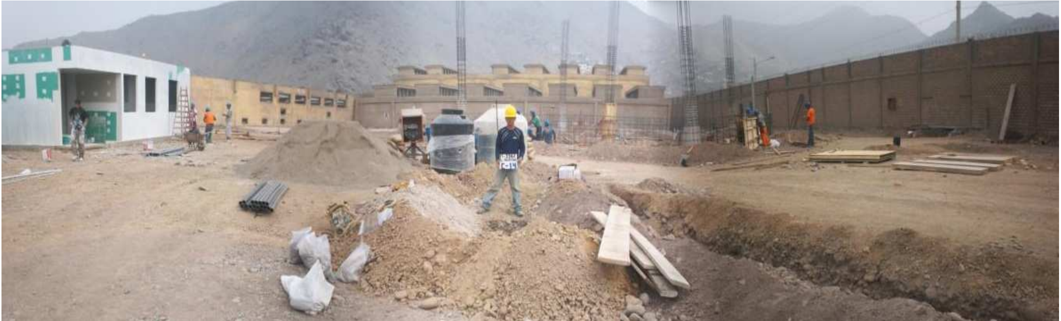
VISTA PANORÁMICA DEL INTERIOR DEL TERRENO ESTUDIADO. SE APRECIA LA UBICACIÓN DE LA CALICATA C-14.
