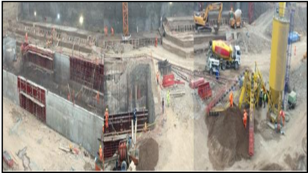
Imagen No 16: Imagen de obra durante vaciado de concreto fluido
