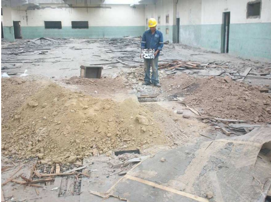
UBICACIÓN DE LA CALICATA C-45.
