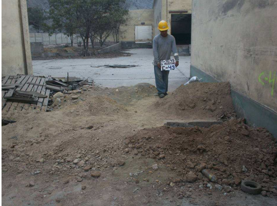
UBICACIÓN DE LA CALICATA C-49.
