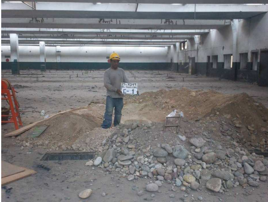
UBICACIÓN DE LA CALICATA C-1.
