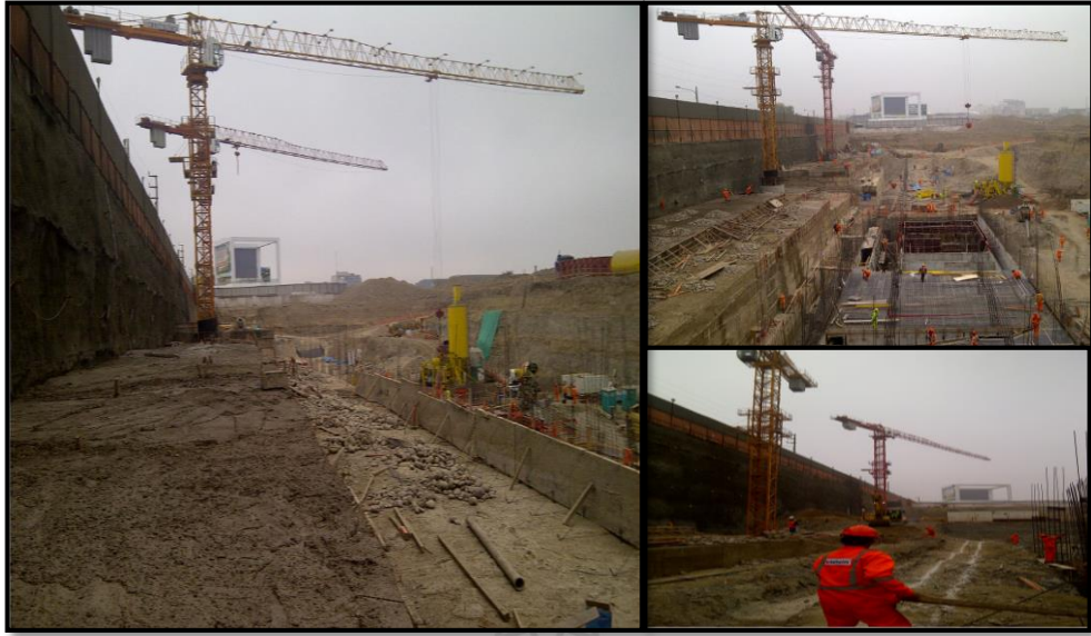
Imagen No 14: Torres grúas en obra
