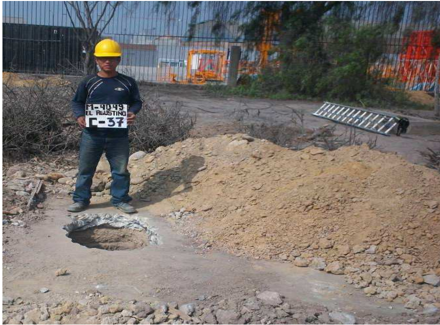
UBICACIÓN DE LA CALICATA C-37.
