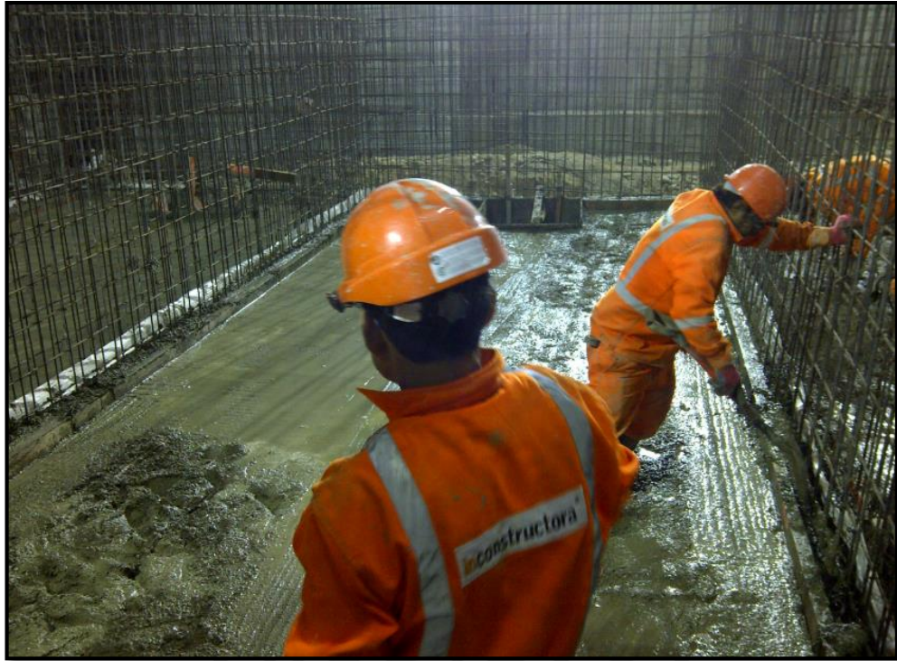
Imagen No 08: Tiempo Productivo – Vaciado de losa
