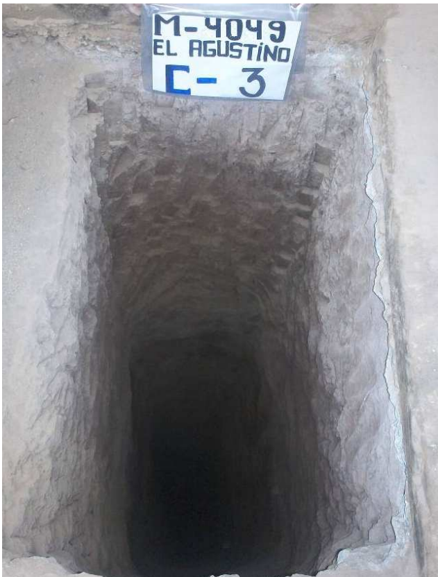
VISTA HACIA EL INTERIOR DE LA CALICATA C-3. SE PUEDE APRECIAR LA LOSA DE CONCRETO DE 0.20 M. DE ESPESOR APOYADA SOBRE UNA CAPA DE ARENA FINA, ARCILLOSA.
